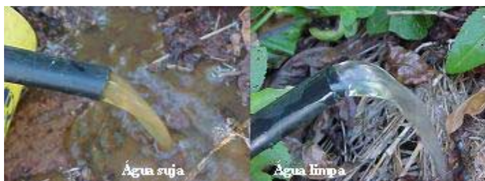
Figura 3.9 – Detalhe da abertura de final de linha mostrando a eliminação de partículas desprendidas e a água limpa após o processo de limpeza.
