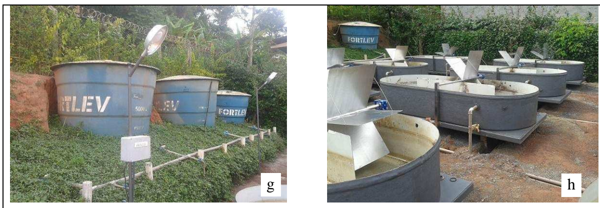
Figura 36. Fotografias das unidades de armazenamento e tratamento do efluente de fossa no LESA. Reservatórios de esgoto (a), lagoas de alta taxa em escala piloto no LESA(b).
