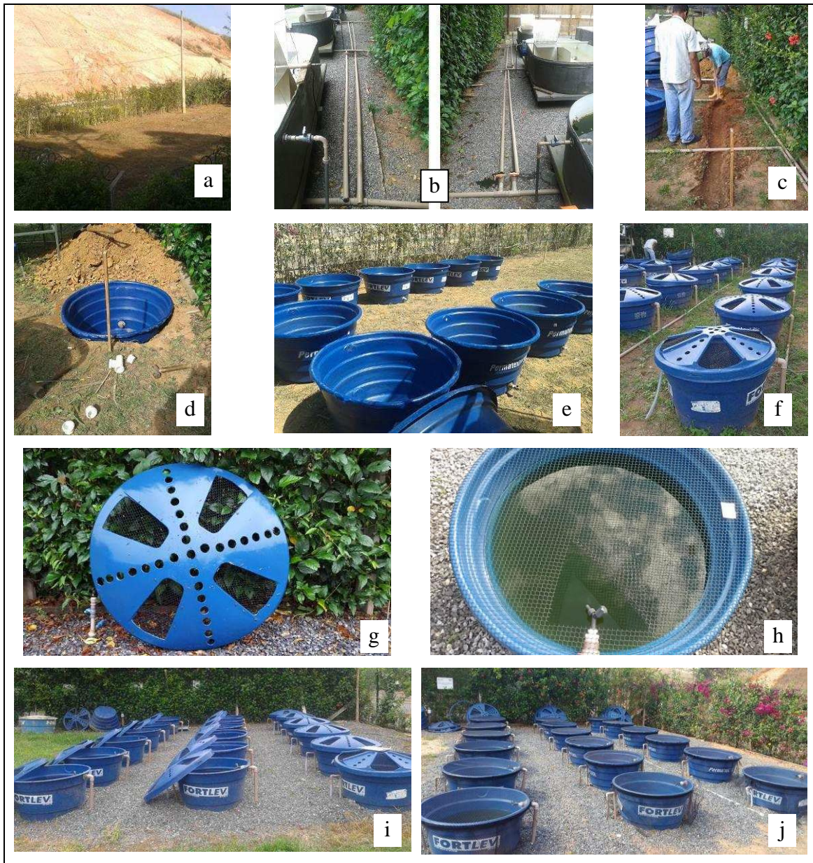
Figura 40. Montagem do experimento para criação das tilápias em tanques recebendo efluente de LAT. Local selecionado para os experimentos (a), tubulações para transporte com efluente das LAT (b), redes principais para transporte do efluente dos tanques (c), tanque enterrado recebendo o efluente dos tanques (d), localização dos tanques de cultivo (e), montagem hidráulica da rede de distribuição do esgoto tratado (f), tampa perfurada utilizada nos dois primeiros experimentos (g), tela plástica, com abertura, utilizada no terceiro experimento (h), vista geral dos tanques de cultivo no primeiro e segundo experimentos (i), vista geral dos tanques de cultivo no terceiro experimento (j).
