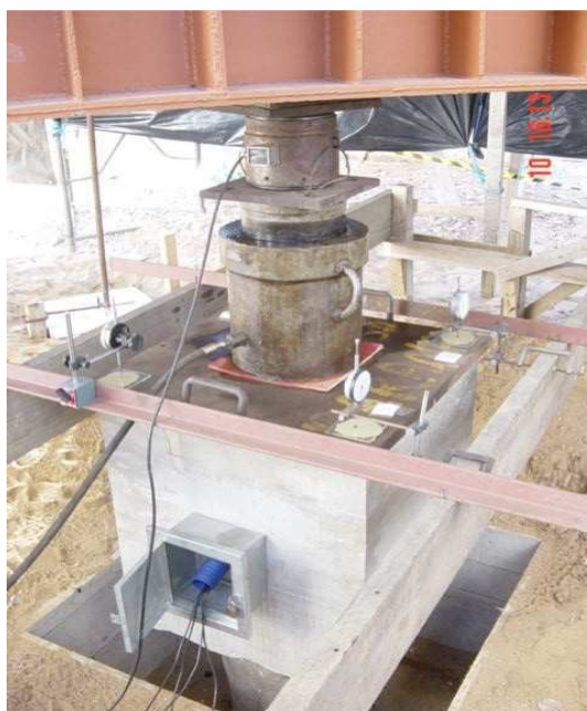
Figura 3.19 – Cabo da instrumentação saindo pela lateral do bloco
