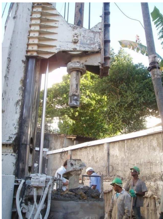
Figura 3.9 – Abertura do trado para introdução do tubo galvanizado
