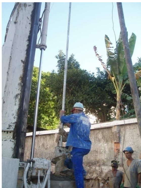
Figura 3.10 – Introdução do tubo galvanizado
