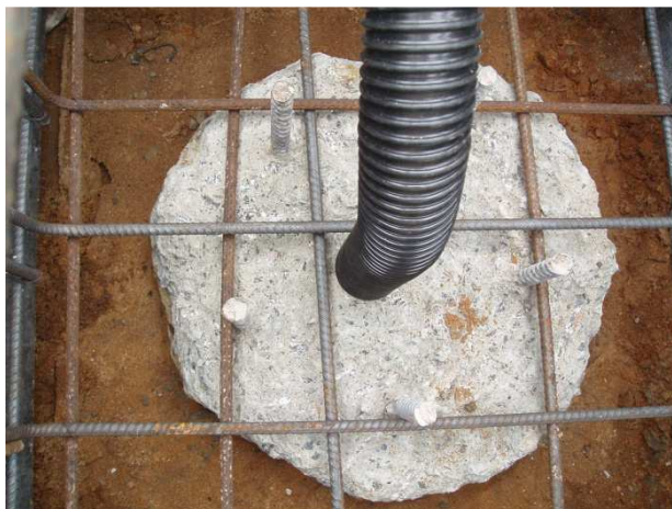
Figura 3.18 – Adaptação de tubo flexível no tubo galvanizado
