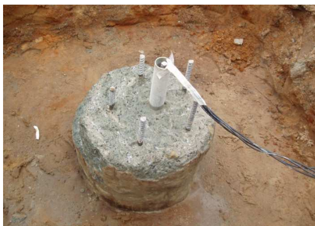
Figura 3.17 – Saída do cabo da instrumentação do interior da estaca
