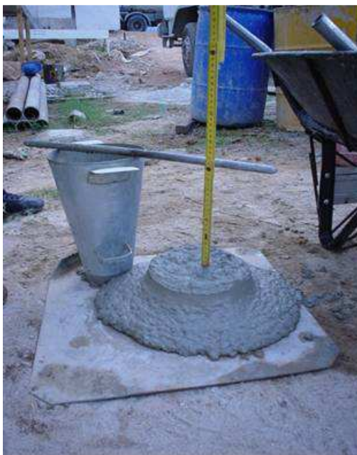
Figura 3.12 – Controle de concreto na obra – medida do slump test
