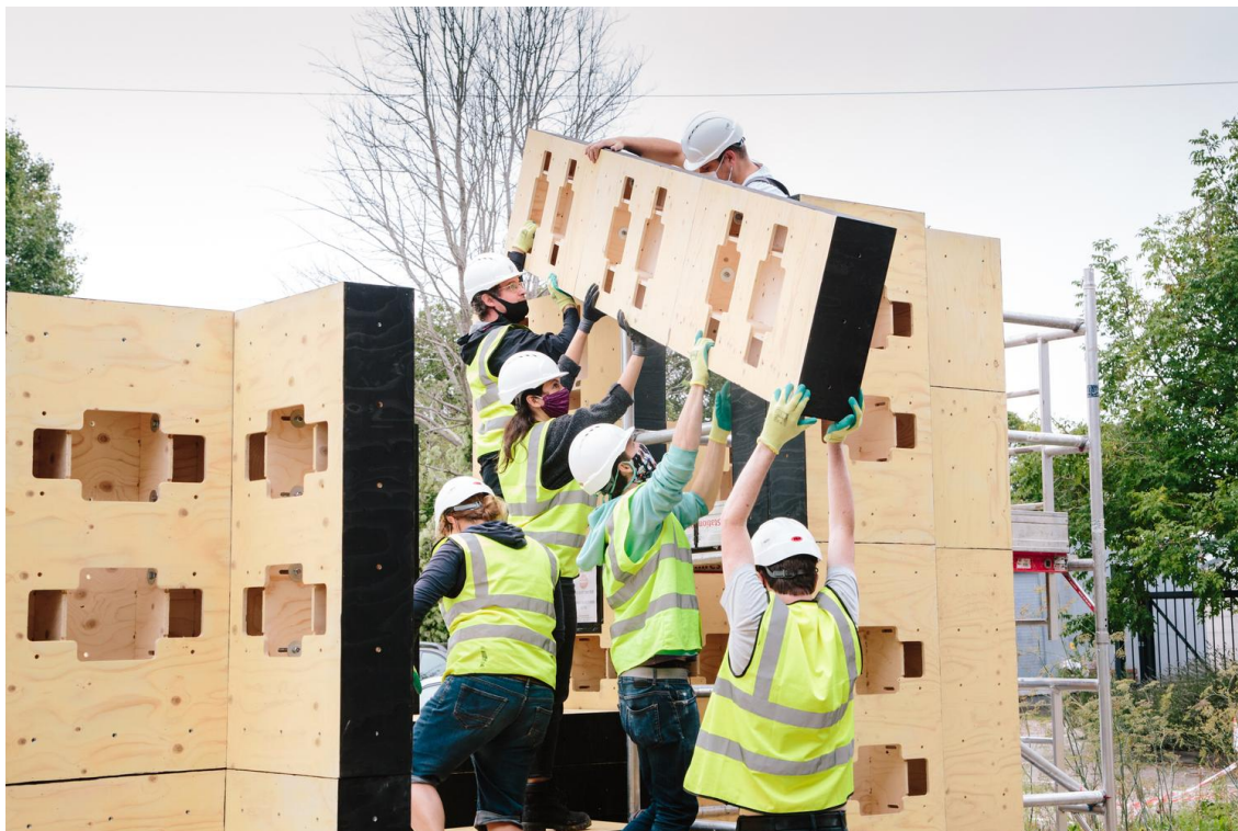
Figura 43: Montagem do Block West Pavilion
