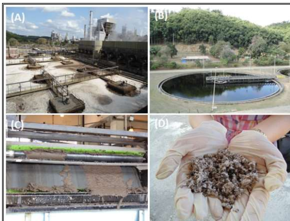
Figura 1. Sistema de lodos ativados da CENIBRA. (A) Tanque de aeração; (B) decantador; (C) prensa para desaguar o lodo secundário; (D) lodo primário.
