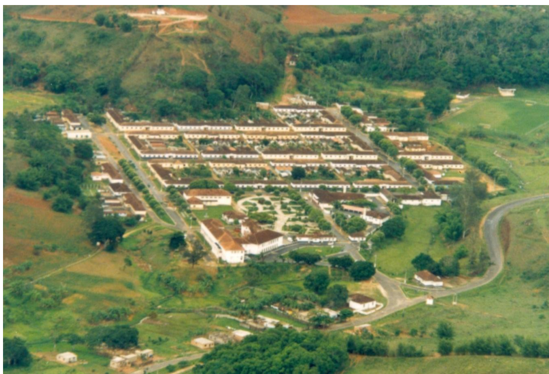
Foto 1 - Vista aérea da Casa de Saúde Padre Damião (1995).
