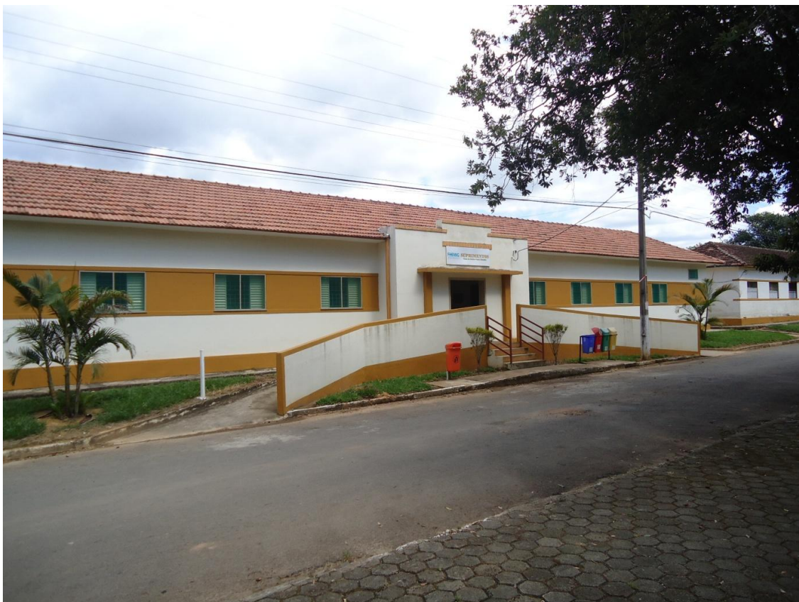
Foto 11 - Pavilhão reformado: uso administrativo.
