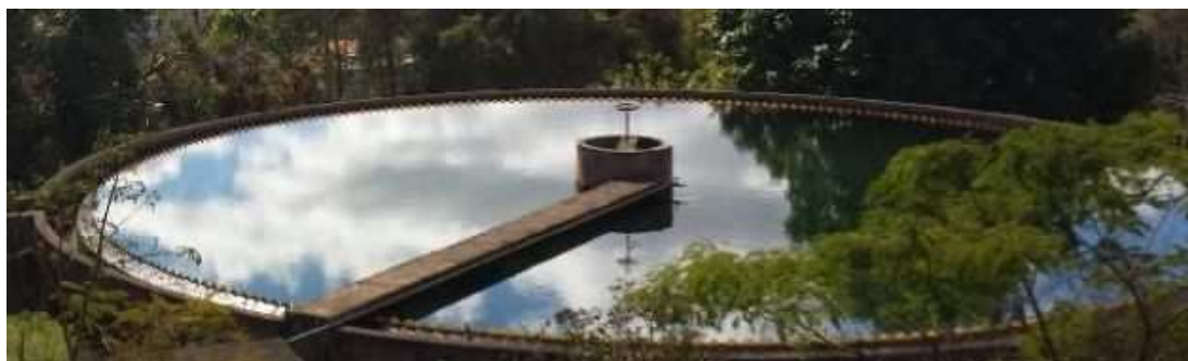
Figura 19. Caixa de decantação da ETA.
