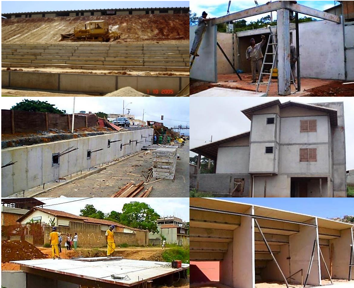
Figura 1.2 – Obras construídas com elementos de concreto envelopados.
