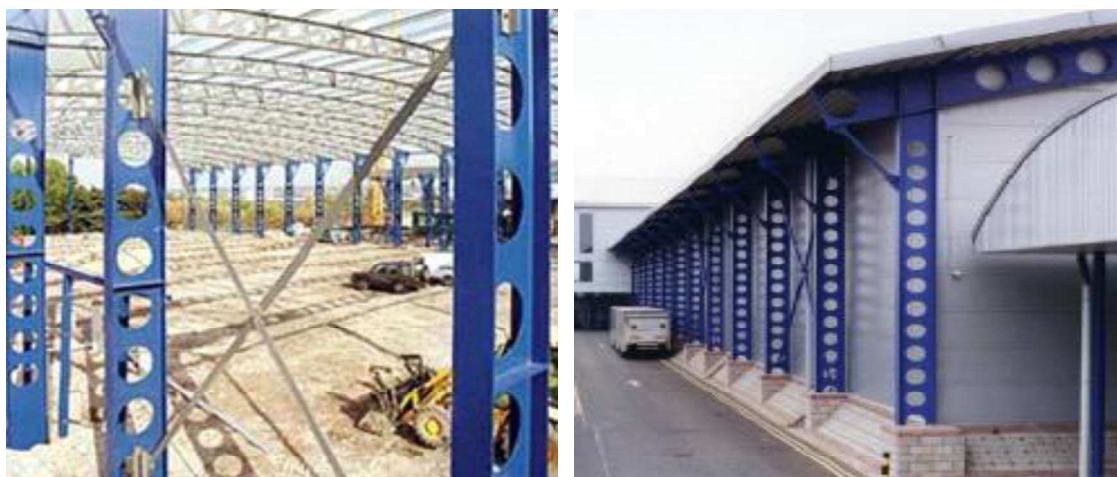
Figura 7 – Perfis celulares utilizados como pilares e elementos constituintes de pórticos rígidos (VERWEIJ, 2010).
