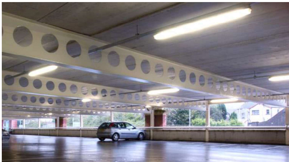
Figura 6 – Capacidade de perfil celular em vencer grandes vãos (WESTOK, 2017).
