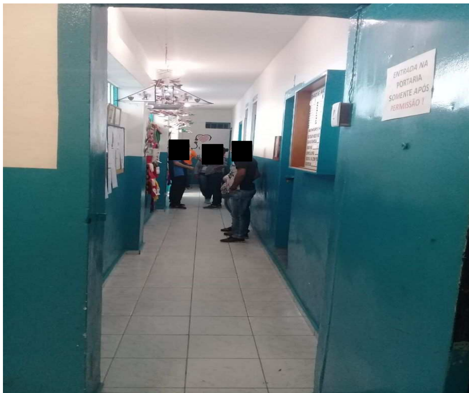
Figura 14 – Corredor de acesso ao interior do estabelecimento.
