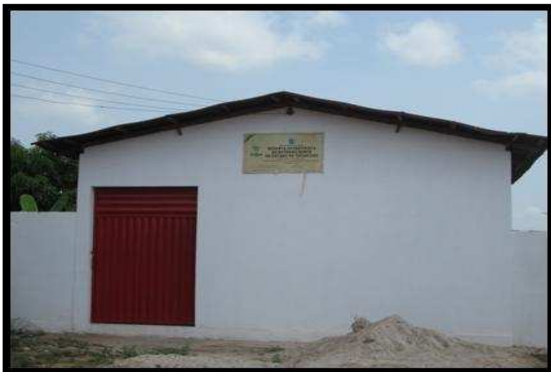
Figura 9 – Fachada da sede da Usina de Beneficiamento da Produção do Óleo Babaçu (Povoado Vinte Mil, 2014)
