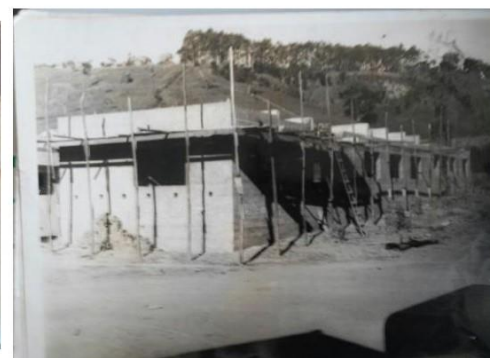
Figura 4: Construção dos prédios do Centro de Treinamento em Viçosa – Sem data
