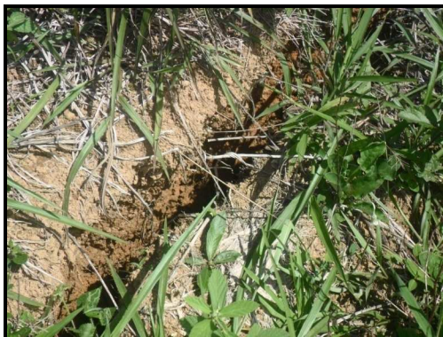
Figura 9: Formação de trinca no solo – estágio inicial.
