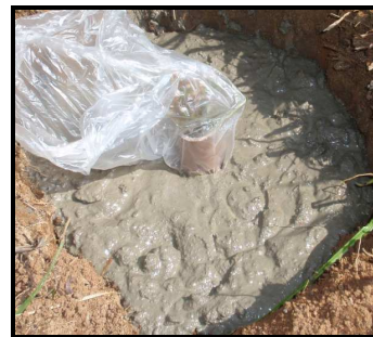
Figura 17: Processo de instalação de marco.
