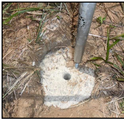
Figura 13: Marco local em processo de montagem.
