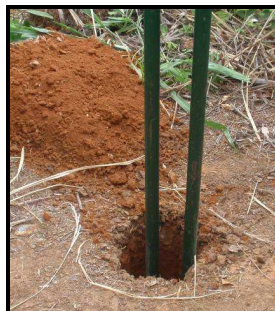
Figura 16: Realização de cava para implantação de marco.
