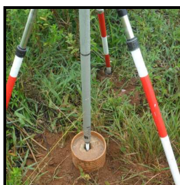
Figura 19: Processo de instalação do pino de centralização - ajuste do pino no pilar.
