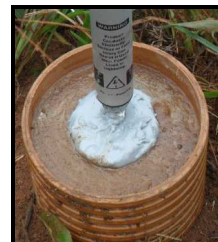
Figura 20: Processo de instalação do pino de centralização – fixação do pino no marco.
