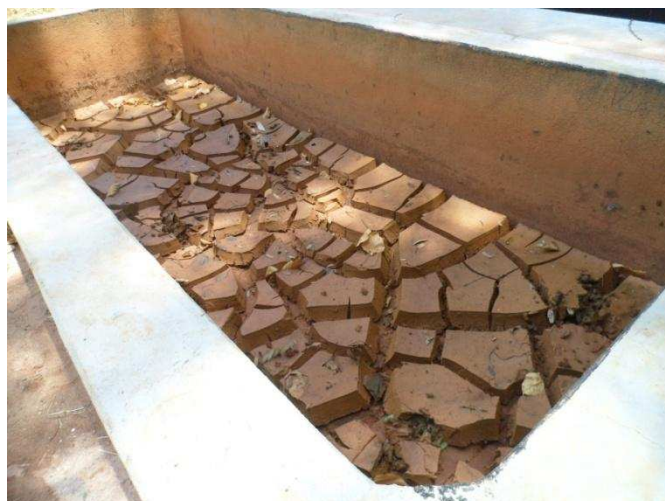
Figura 4.8 – Aspecto do lodo após período de desaguamento no leito de secagem piloto.
