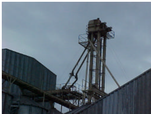
Figura 3.9. Vista do sistema de movimentação de grãos.
