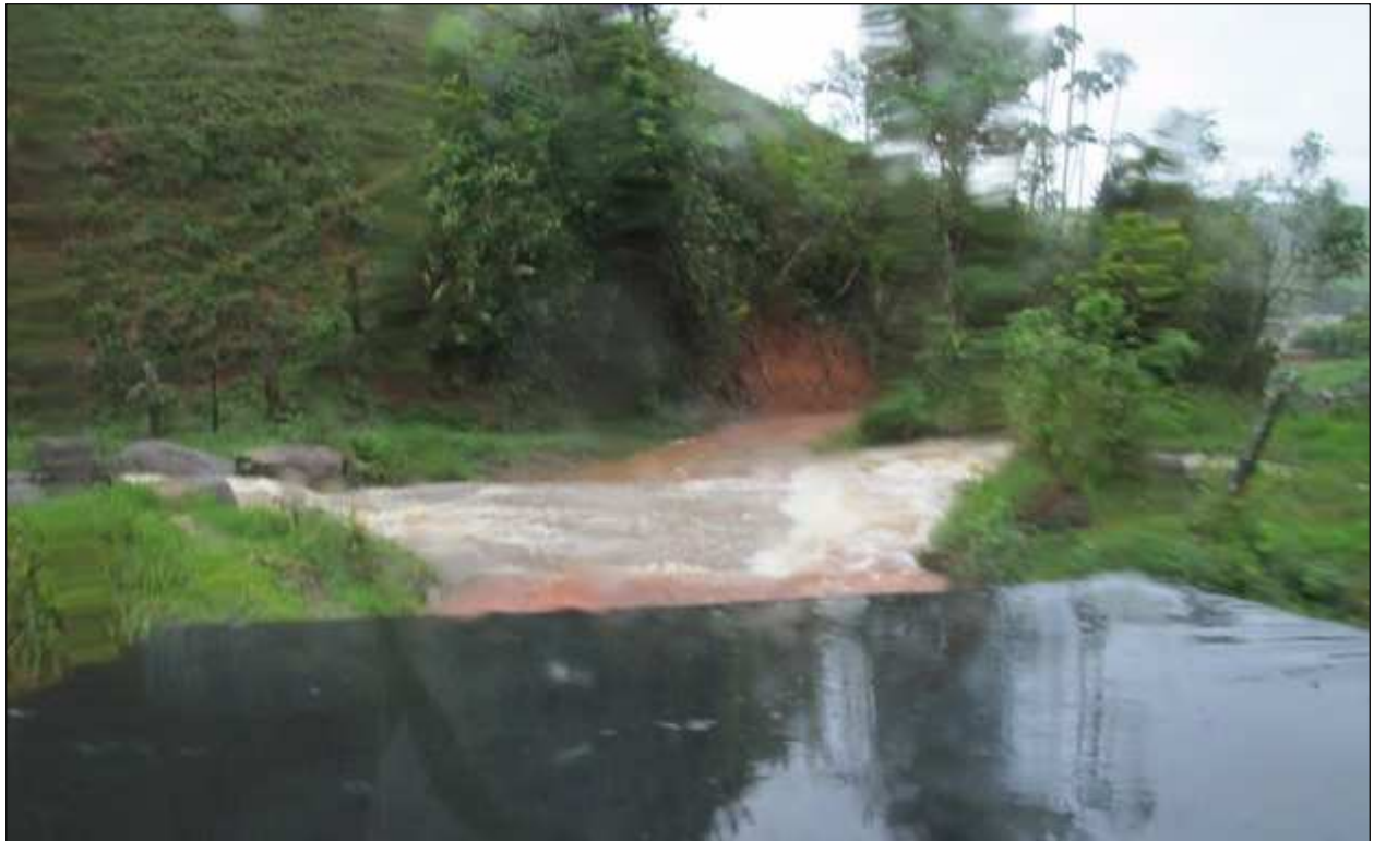
Figura 17 - Condições do acesso no momento da validação em campo.
