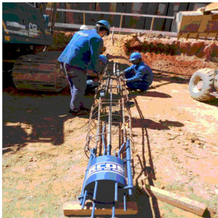
Figura 16 - Célula implantada na armadura da estaca.
