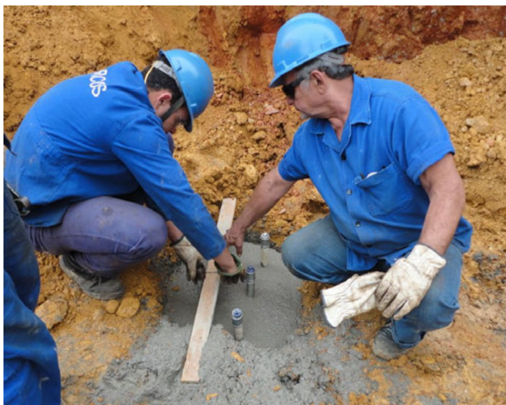
Figura 21 - Fixação dos quatro tubos do sistema de reação.
