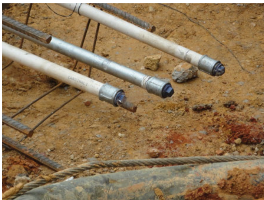
Figura 4 - Detalhe dos tubos tamponados, fixados na célula.
