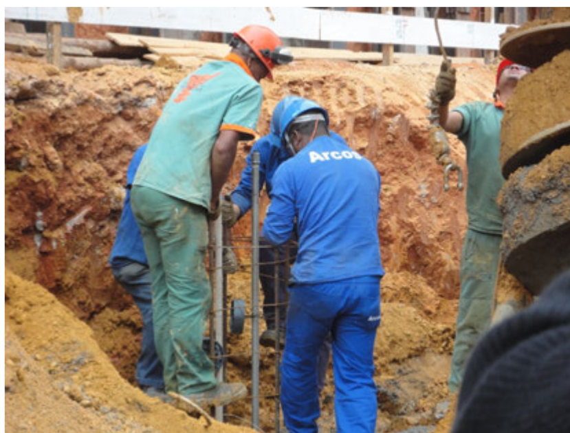
Figura 6 - Detalhe mergulho do conjunto, gaiola armada e célula, na estaca (concreto fresco).
