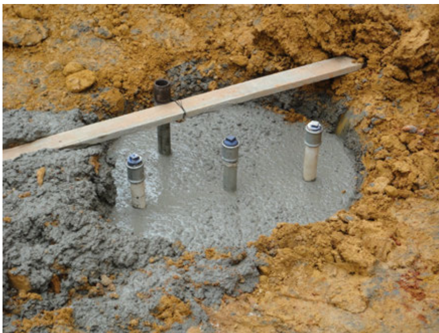
Figura 5 - Detalhe da gaiola armada mergulhado no concreto fresco, três tubos interligados com a célula e a fixação de um quarto tubo em PVC, na superfície do fuste em aproximadamente um metro.
