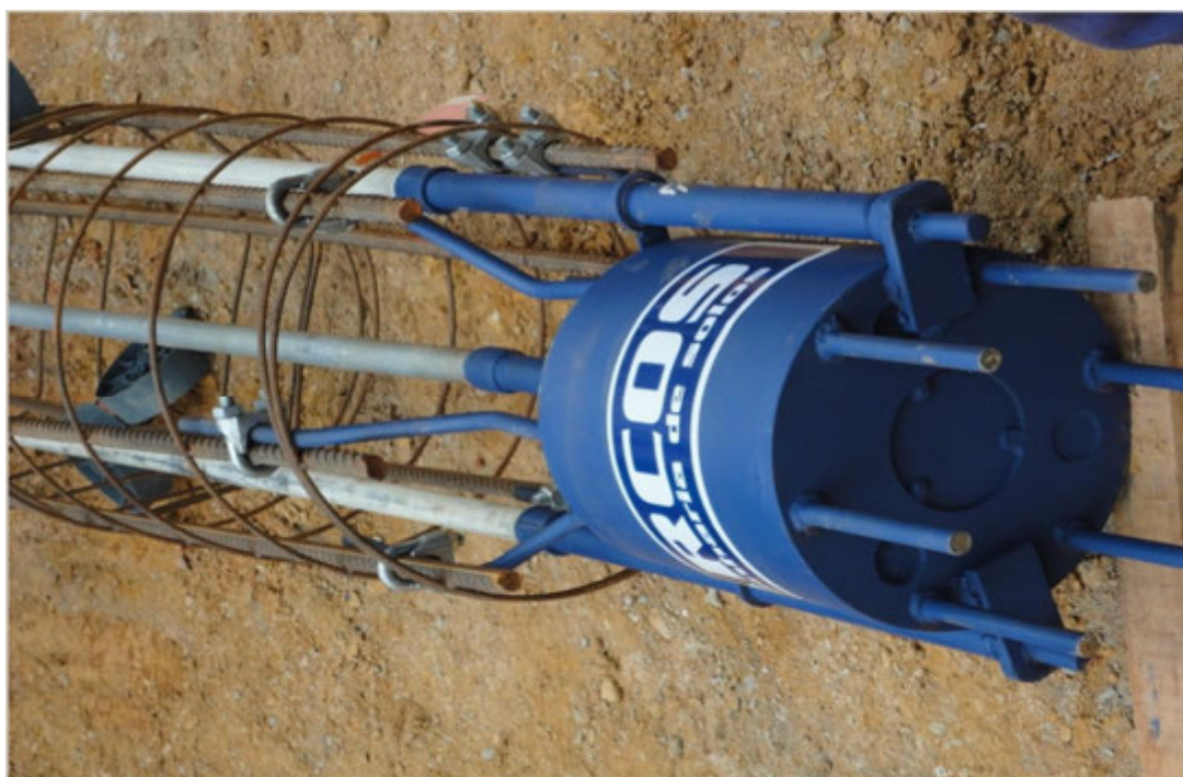
Figura 17 - Célula hidrodinâmica expansiva.
