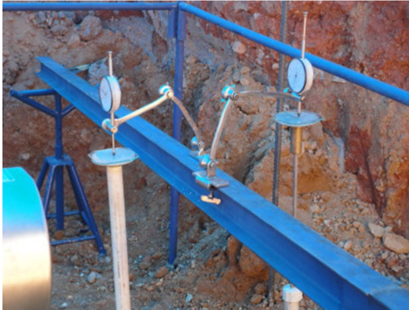
Figura 10 - Detalhe dos deflectômetros fixados na barra rígida (sistema de referência).
