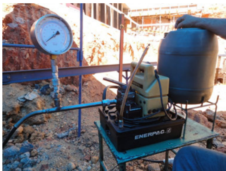
Figura 11 - Detalhe de montagem do manômetro.
