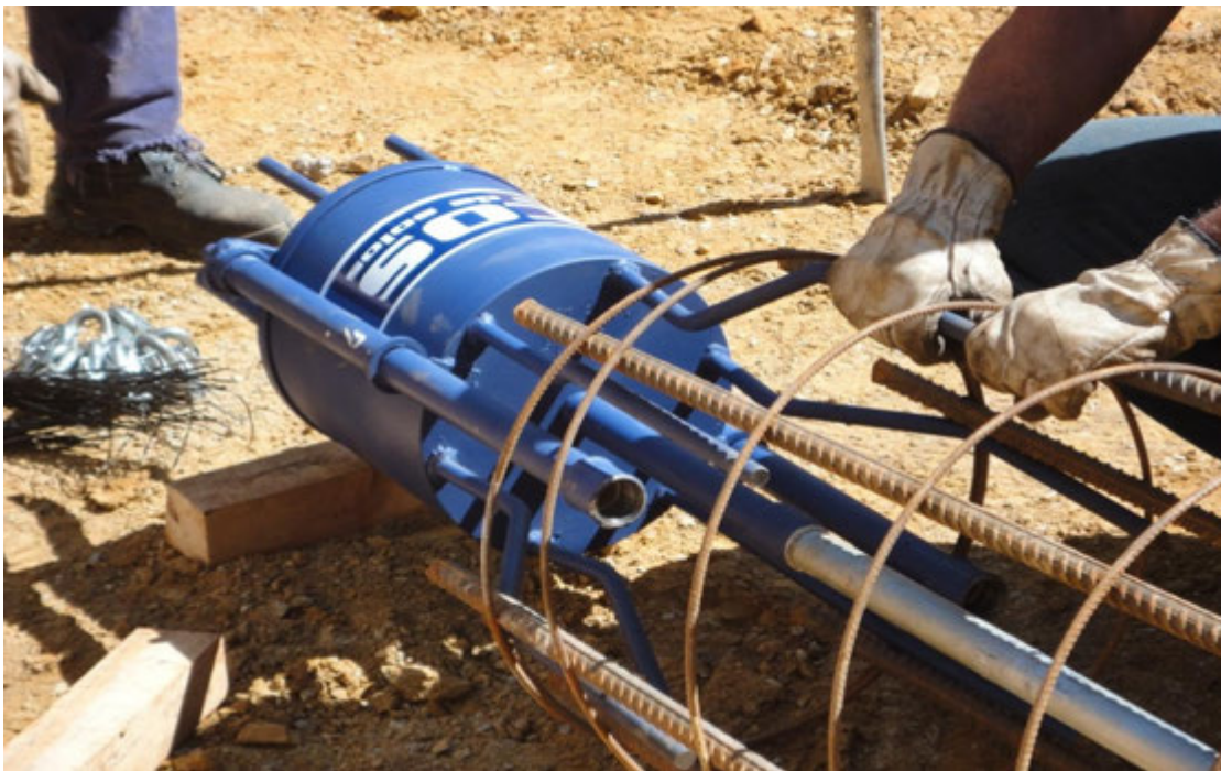
Figura 19 - Célula sendo implantada na armadura da estaca.
