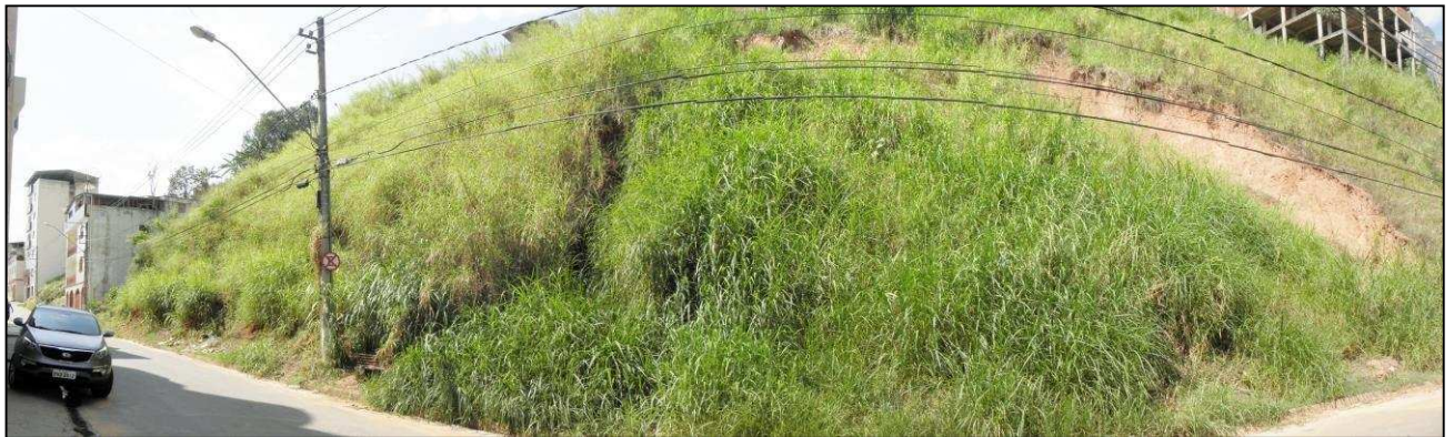
Figura 61 - Vista do talude da área 2.
