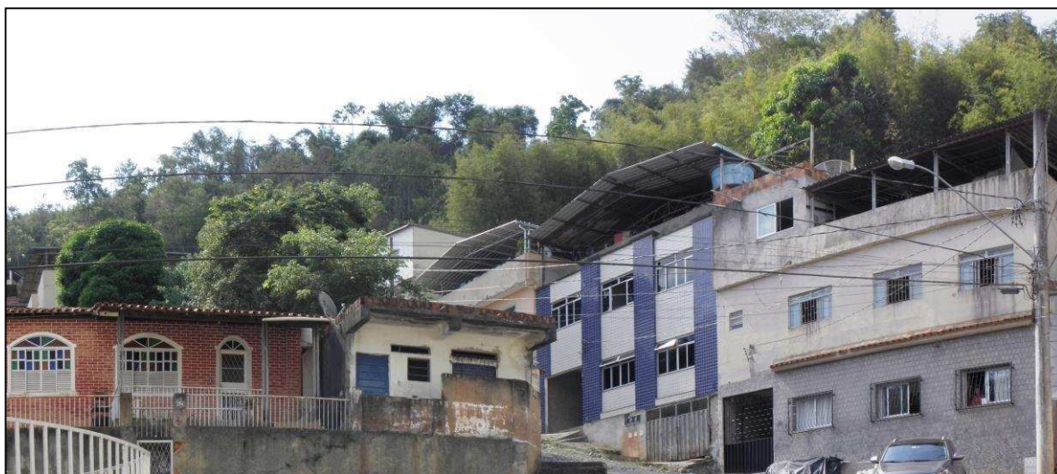
Figura 63 - Imóveis que podem ser atingidos vistos da parte de baixo do talude.
