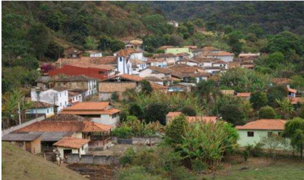
Figura 7. Vista panorâmica do centro urbano do distrito de São Bartolomeu, Ouro Preto/MG. Fonte: dados da pesquisa de campo, 2015.
