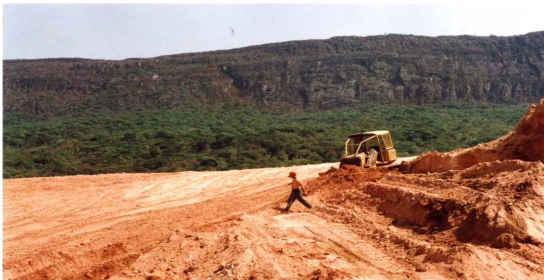
Foto: Luiz Cruz (Acervo do Corpo de Bombeiros Voluntários de Tiradentes) Figura 4 – Loteamentos nos limites da APA São José, em Tiradentes, MG.
