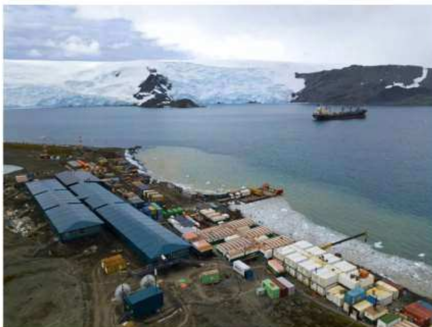
A nova estação de pesquisa brasileira Comandante Ferraz, na Ilha Rei George, está em fase final de construção e deve ser inaugurada em Março Foto: Clayton de Souza/Estadão
