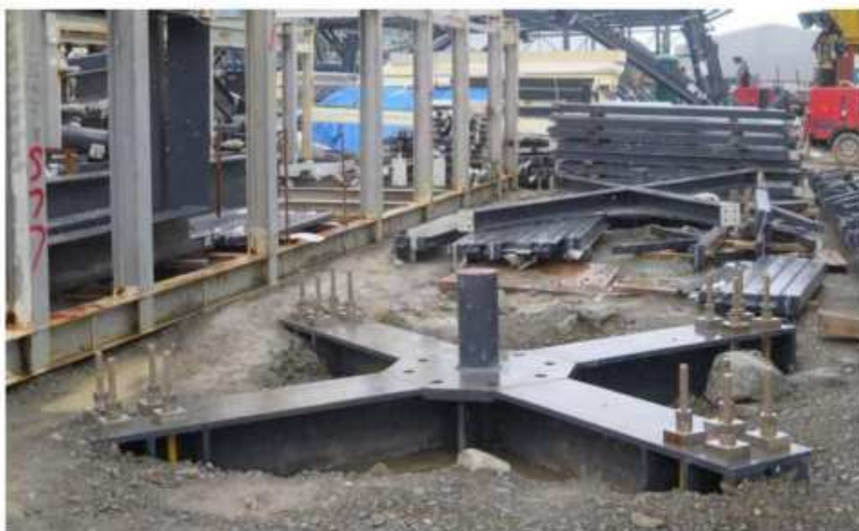
No verão, os trabalhos de construção seguem a todo vapor Foto: Monica Gugliano
