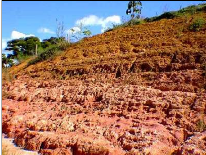
Figura 3.2 – Talude escolhido para análise (Viçosa-MG).
