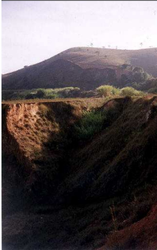
Figura 3.4 – Sistema de drenagem que deflagrou o processo erosivo próximo à rodovia BR-120, na Serra de São Geraldo (Coimbra, MG).
