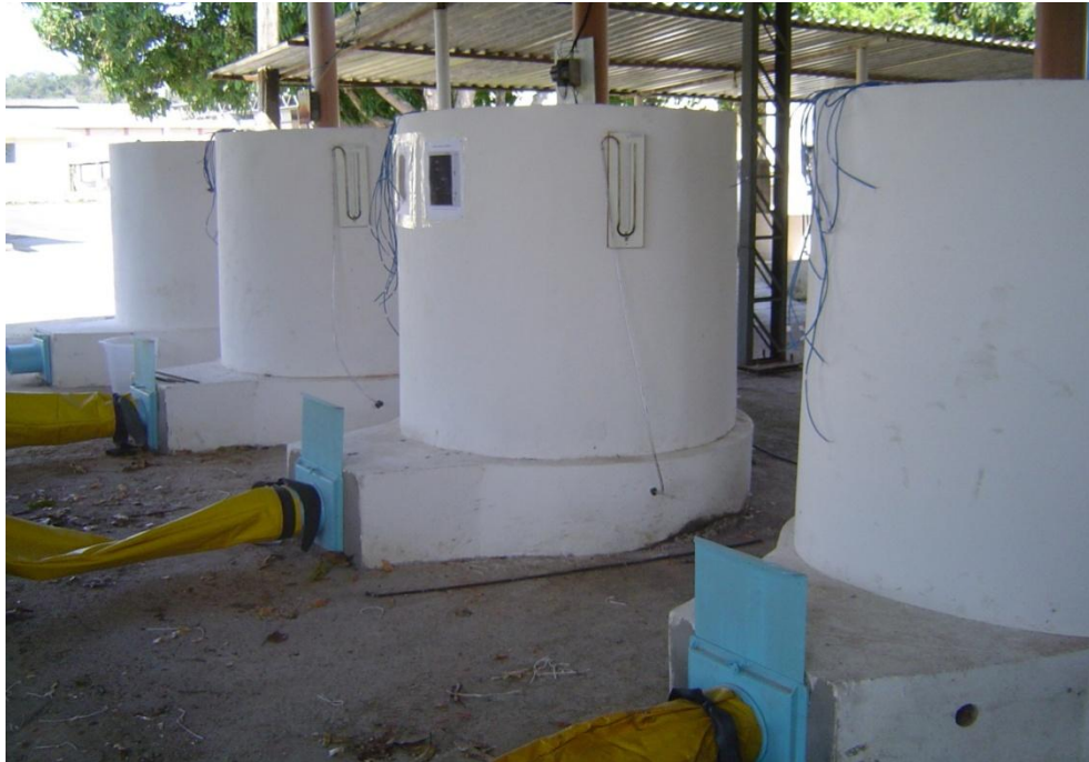
Figura 1. Vista parcial dos silos onde foi realizada a cura artificial.
