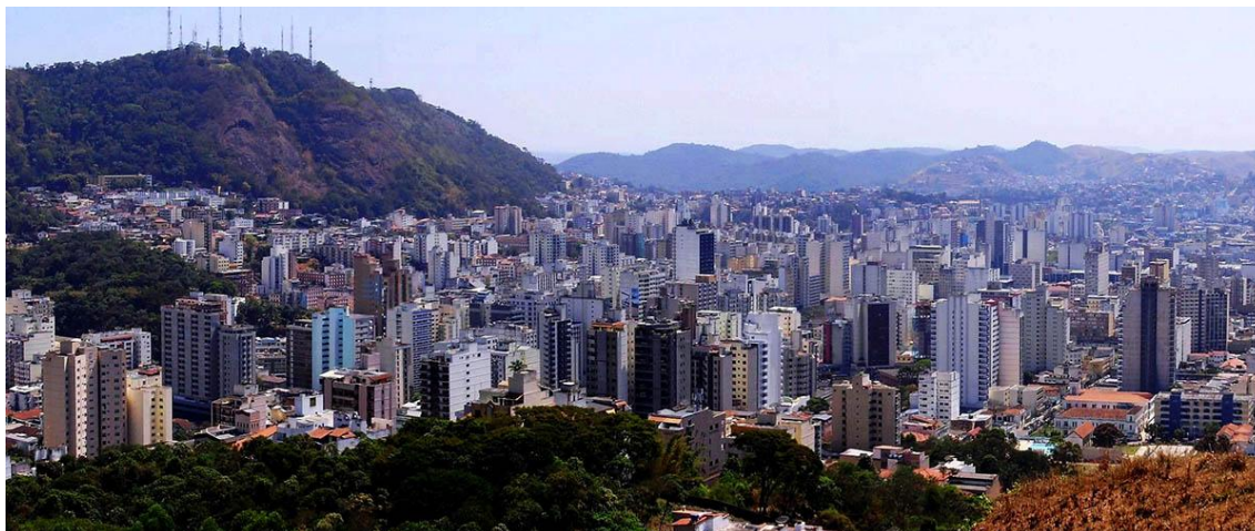
Figura 08 Vista panorâmica da cidade de Juiz de Fora. Fonte: Cidades Em Fotos.
