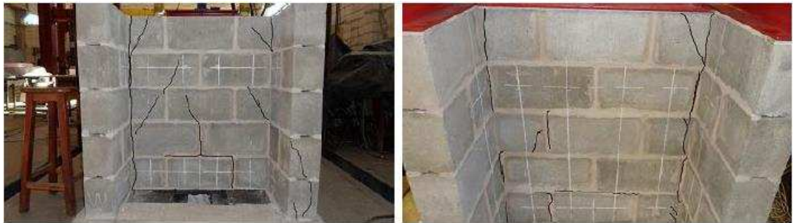
Figura 4-9- padrão de fissuração dos modelos da Série 1, na parede central.
