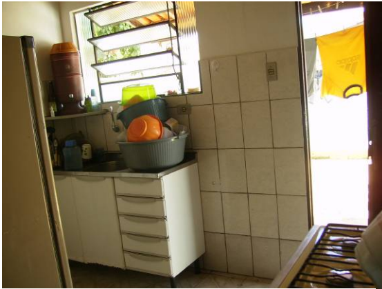
Figura 6.20: Adição de revestimento cerâmico à meia parede da cozinha e troca da pia, torneira e acréscimo de armário Figura: Acervo da autora.
