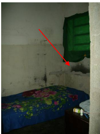
Figura 6.17: Retirada da pia e tampado pontos de água para utilização do ambiente como quarto Fonte: Acervo da autora.
