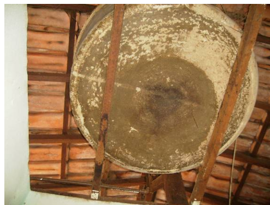
Figura 6.29: Posicionamento da caixa d'água sob o telhado Fonte: Acervo da autora.
