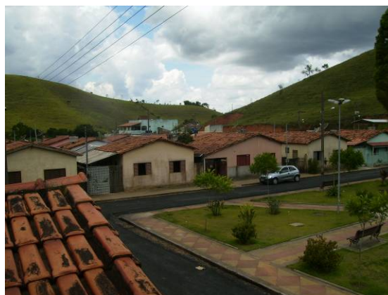
Figura 5.5: Vista parcial da praça e das unidades habitacionais.
