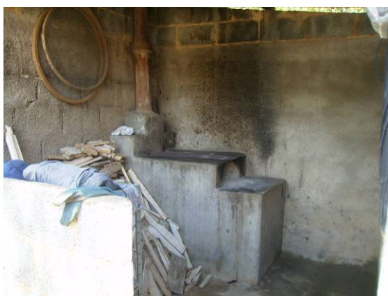
Figura 6.30: Construção de fogões à lenha, como também de um local coberto para sua disposição Fonte: Acervo da autora.
