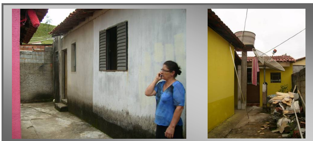
Figura 6.40: Casa construída nos fundos do quintal da casa original e no limite do terreno. Casa 35 (esquerda) e casa e 37 (direita) Fonte: Acervo da autora
