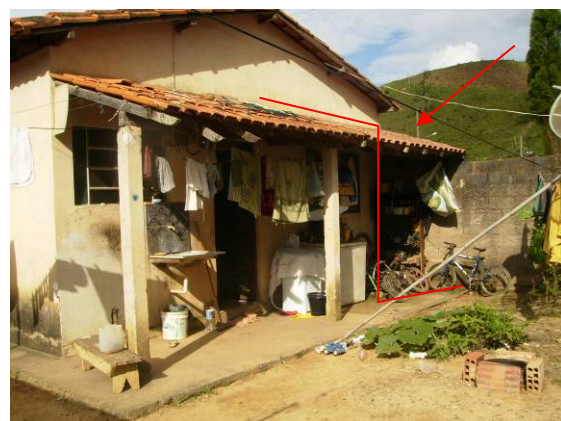
Figura 6.23: Ampliação da cobertura da área de serviço Fonte: Acervo da autora.
