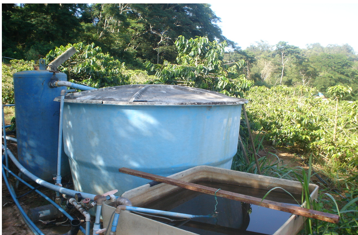
Figura 1. Infra-estrutura utilizada na aplicação de esgoto doméstico. Contendo filtro de areia (esquerda), caixa de armazenamento de esgoto filtrado (centro) e caixa de água (direita).
