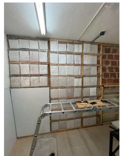
Figura 9 - Projeto (a) e Execução (b) da fixação do PCM macroencapsulados na estrutura de suporte
