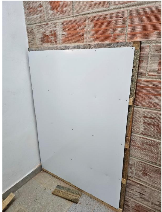
Célula Teste – Fixação Placa ACM
