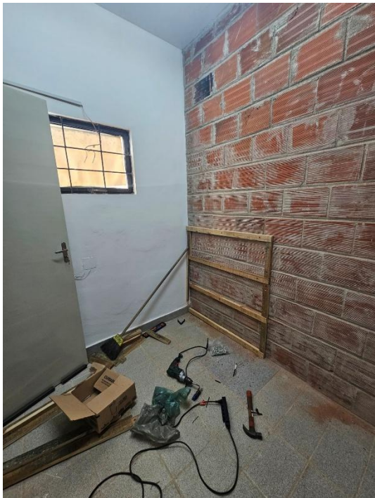
Célula Teste – Fixação Ripas
