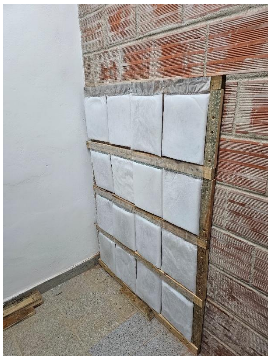
Célula Teste – Fixação Invólucro PCM
