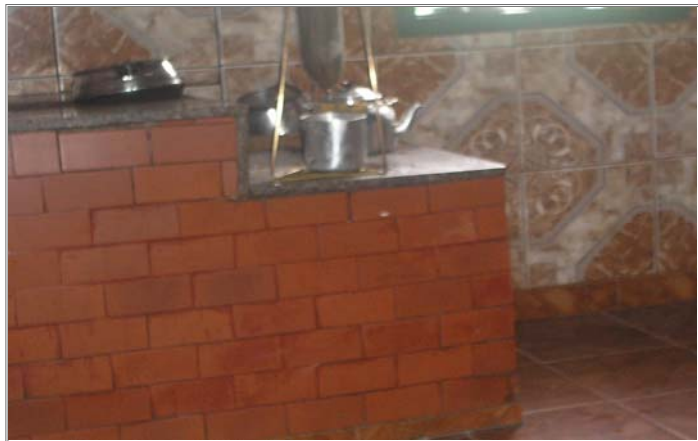
Figura 23: Na cozinha de Zé Gatão, tijolinhos e mármore recobrem o barro. (Foto Alexandra Santos)
