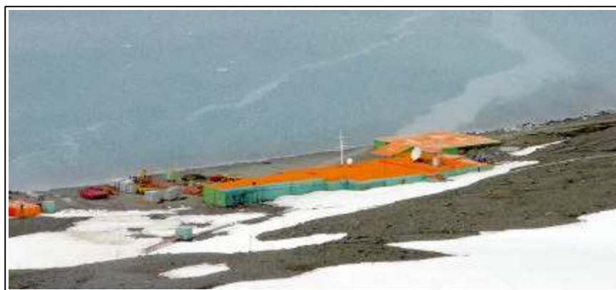
Figura 43 – Mancha de óleo diesel (à esquerda) e de esgoto da EACF (à direita).
