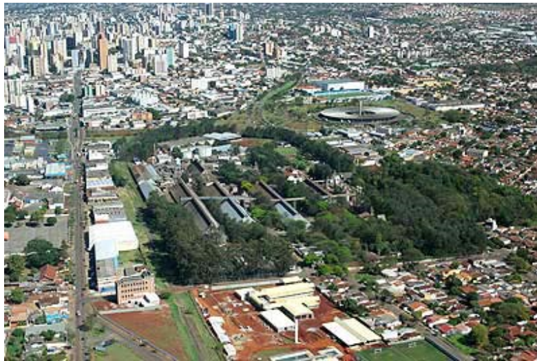
Figura 1: Vista aérea da área destinada ao Teatro de Londrina, com o Bosque do Marco Zero à direita e, ao fundo, a rodoviária da cidade.
