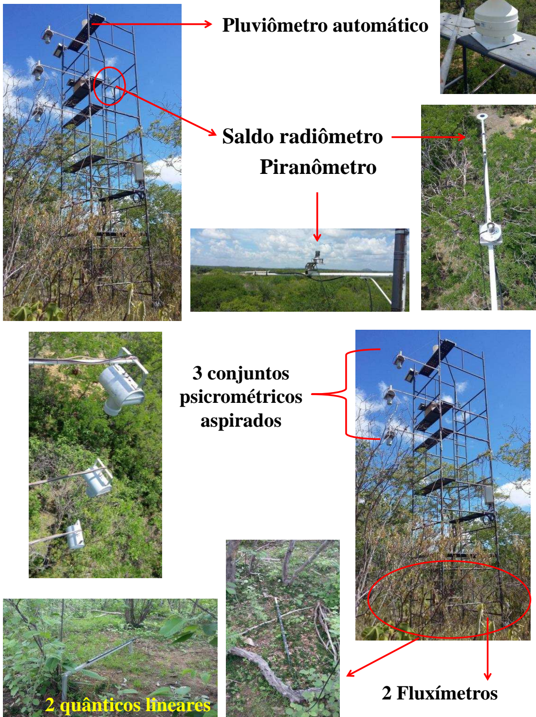
Fig. 3. Instrumentação da torre localizada no sítio do Domínio de Caatinga, no município de Floresta, PE, no Sertão Central do Brasil.
