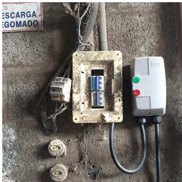
Figura 7 – Quadros de distribuição de circuitos sem a tampa (A e B) e quebrado (B)
