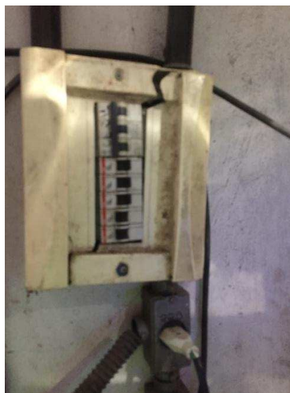
Figura 7 – Quadros de distribuição de circuitos sem a tampa (A e B) e quebrado (B)
