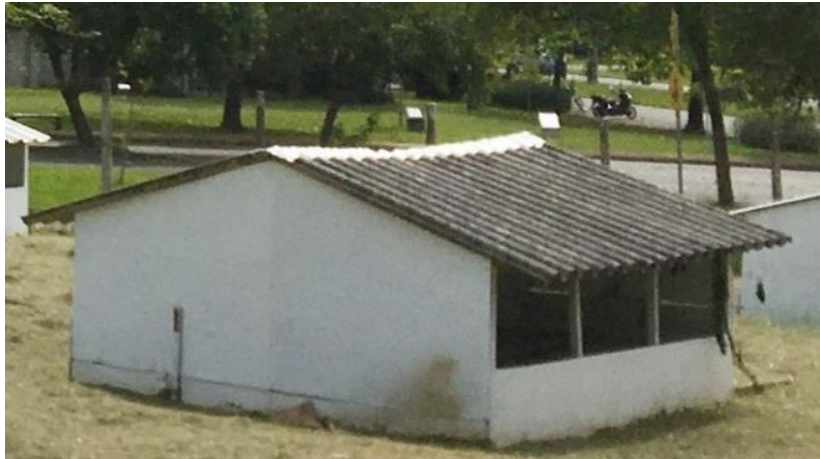
Figura 3. Imagem ilustrativa da coloração escurecida da telha de fibrocimento do protótipo
