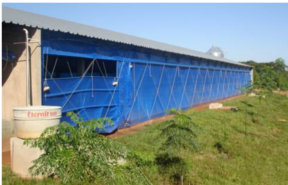
Figura 12. Vista externa do galpão equipado com o sistema de ventilação tipo túnel.
