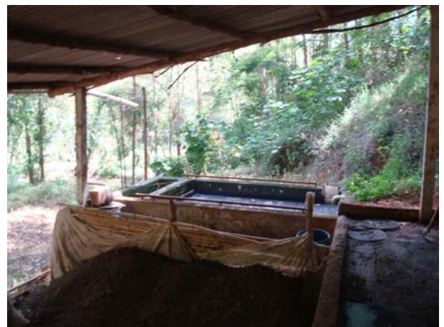
Figura 4.2: Peneira (à esquerda) e caixa de gordura (à direita) instaladas na propriedade.
