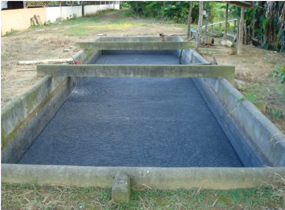
Figura 4.1: Tanque de retenção da ARS.
