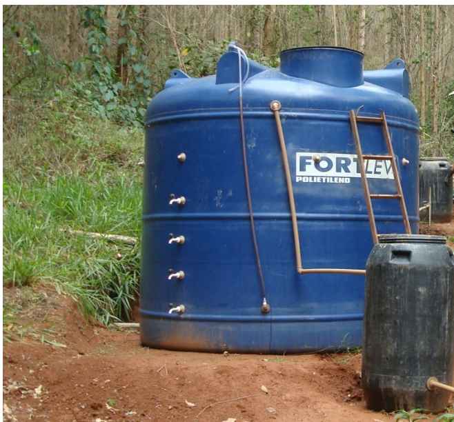
Figura 4.7: Saída do efluente do reator e reservatório 3.
