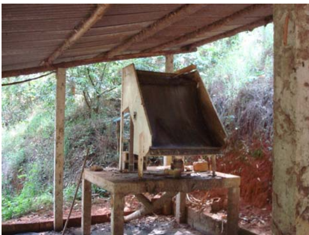
Figura 4.2: Peneira (à esquerda) e caixa de gordura (à direita) instaladas na propriedade.
