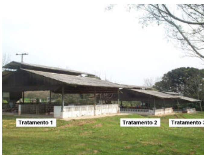
FIGURA 1 – Vista parcial das instalações.
