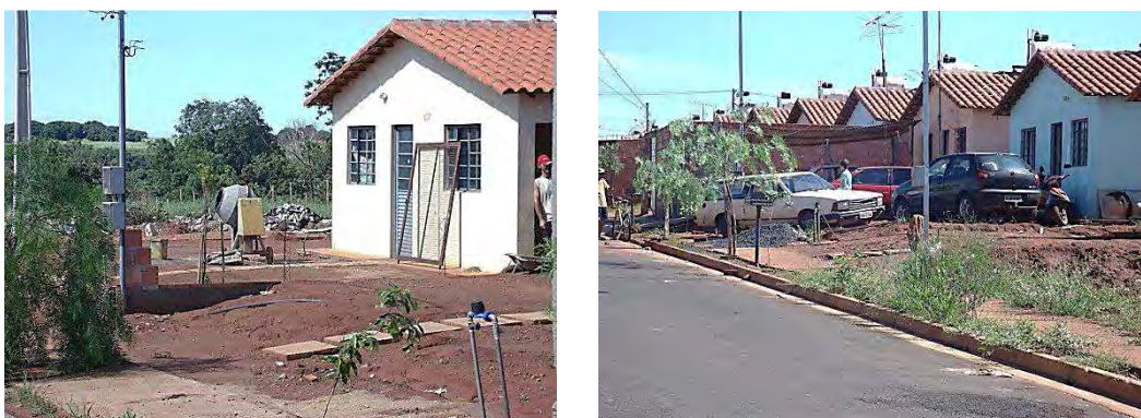
Figura 5.11: Vista das obras em andamento no conjunto Jardim Copacabana (janeiro/2012).
