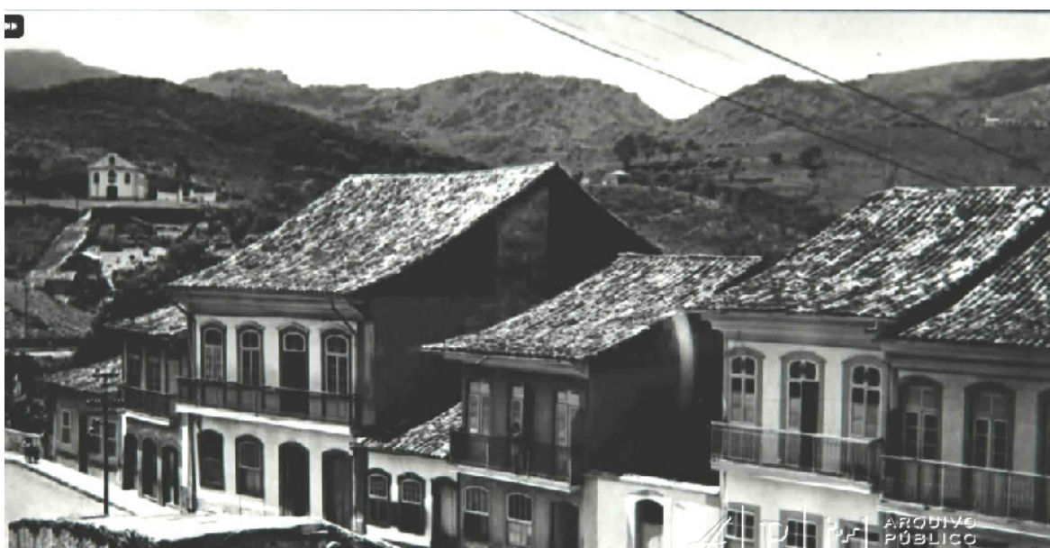
Figura 18: Edificações no bairro Antônio Dias, telhados voltados para a rua em composição harmônica. Fonte: Acervo Público Mineiro. Disponível em: www.siaapm.cultura.mg.gov.br/modules/fotografico_docs/photo.php?lid=29 Acesso dia 20 de dezembro de 2011.
