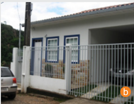
Esquadrias em madeira com vãos verticais conforme exigências atuais do IPHAN. Fonte: Acervo da autora, 2012.
