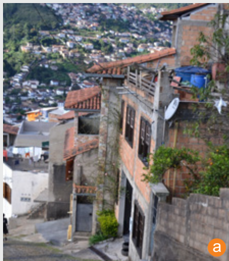
Edificações consolidadas sem pintura e reboco. Fonte: Acervo da autora, 2012.
