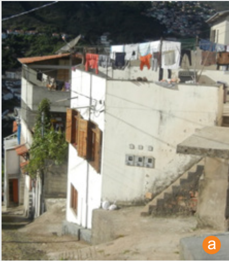
Varanda na cobertura da edificação já consolidada. Fonte: Acervo da autora, 2012.
