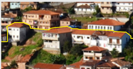
Panorâmica mostra as mesmas edificações e seus pavimentos abaixo do nível da rua. Fonte: Tamara Marques, 2012.
