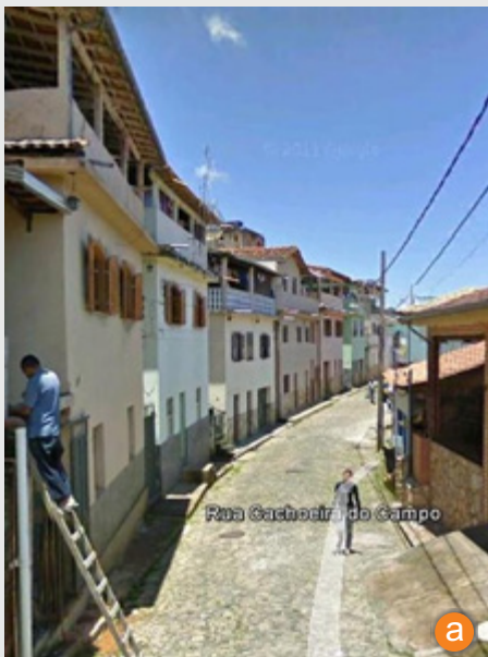
Conjunto de Edificações em 3 pavimentos. Fonte: Google Street View, 2012.
