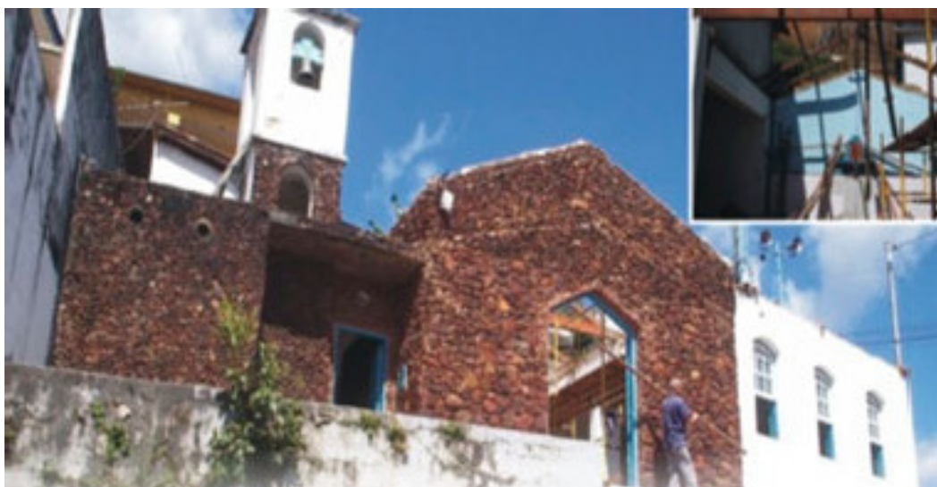
Figura37: Foto da Capela no início da reforma em 2009 ainda com a pedra canga recobrimdo a fachada. Fonte: http://www.paroquiansdc.com.br/index/destaque.php?iddestaque=17 . Acesso em 20/02/2012
