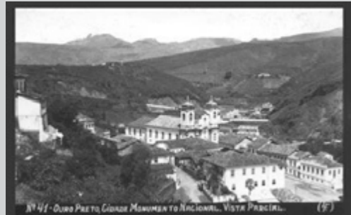
Vista parcial da cidade em 1935. Fonte: Acervo IFAC/UFOP.
