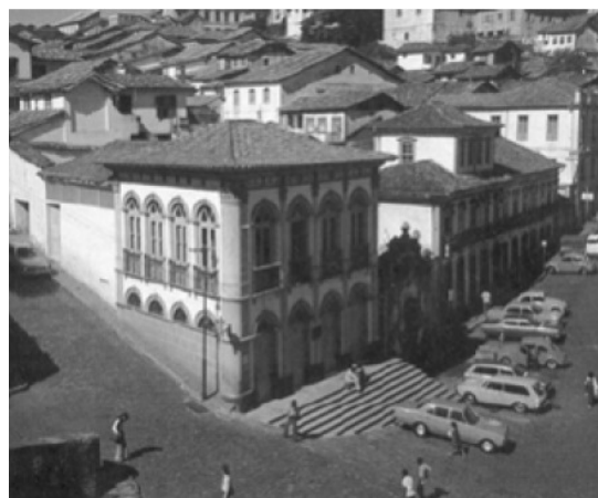
Figura 21: O mesmo sobrado com cobertura colonial. Fonte: PESSOA, 2005, p.12.
