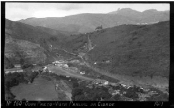
ENCOSTA DESOCUPADA ENTE 1923 E 1950. FONTE: IFAC/UFOP.
