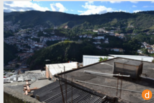
Conjunto de edificações com lajes, telhas metálicas e de amianto. Fonte: Tamara Marques, 2012.
