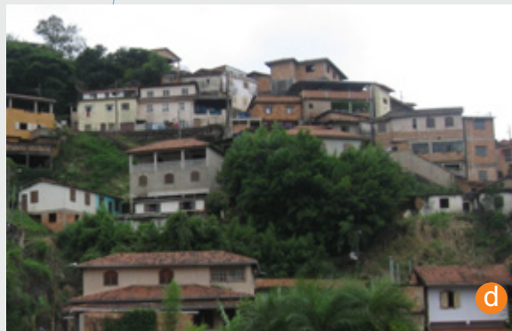
d Pelas fachadas das edificações nota-se a irregularidade da aplicação dos parâmetros do IPHAN. Fonte: Acervo da autora, 2012.
