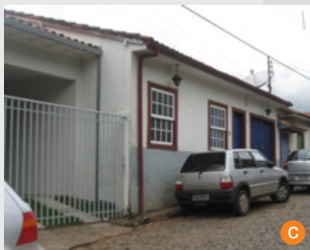
Edificação de acordo com as exigências do IPHAN. Fonte: Acervo da autora, 2012.
