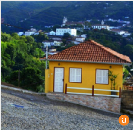
a Esquadrias e telhado de acordo, porém a alvenaria foi pintada com cor escura. Fonte: Tamara Marques, 2012.
