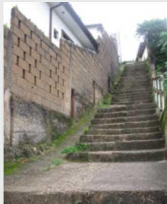
Escadaria da Travessa 21 de Abril. Condições de acessibilidade precárias. Fonte: Acervo da autora, 2012.
