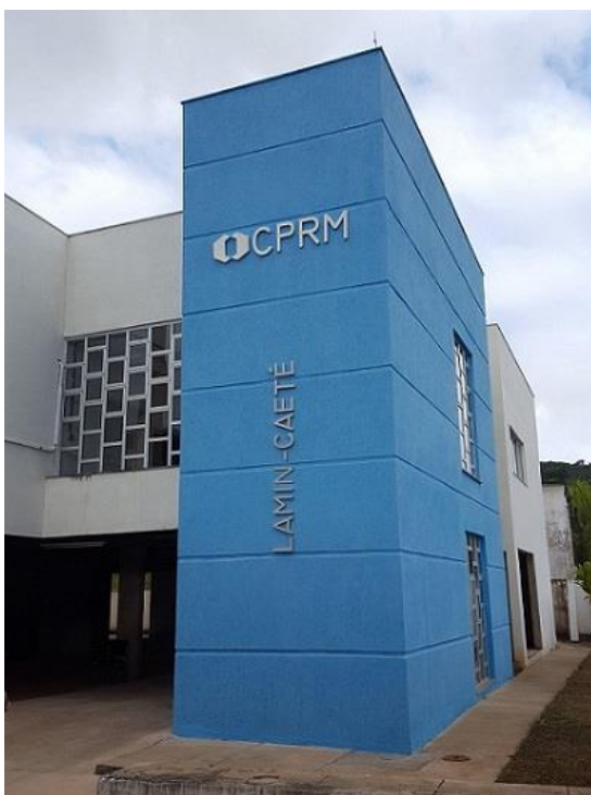
Figura 11: Prédio do Serviço Geológico do Brasil (CPRM) em Caeté/MG
