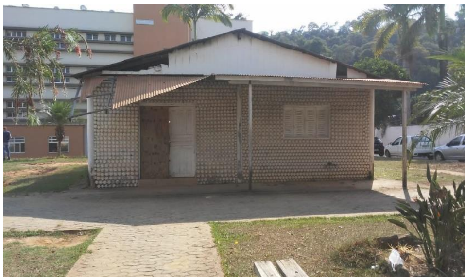
Figura 38 - Vista da frente da Casinha de Pet da Praça de Alimentação da Feira
