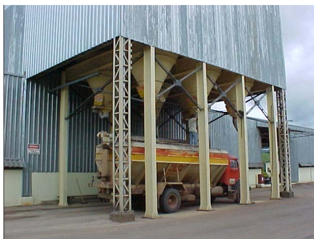
Figura 15. Vista do sistema de expedição de ração a granel.
