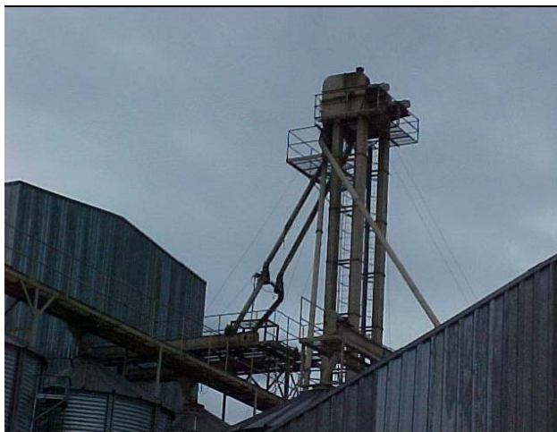
Figura 9. Vista parcial dos transportadores de caçambas e de correntes.
