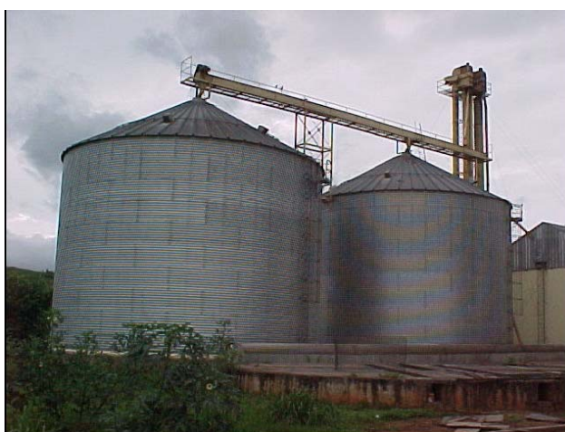
Figura 10. Vista parcial do sistema de armazenagem de milho.
