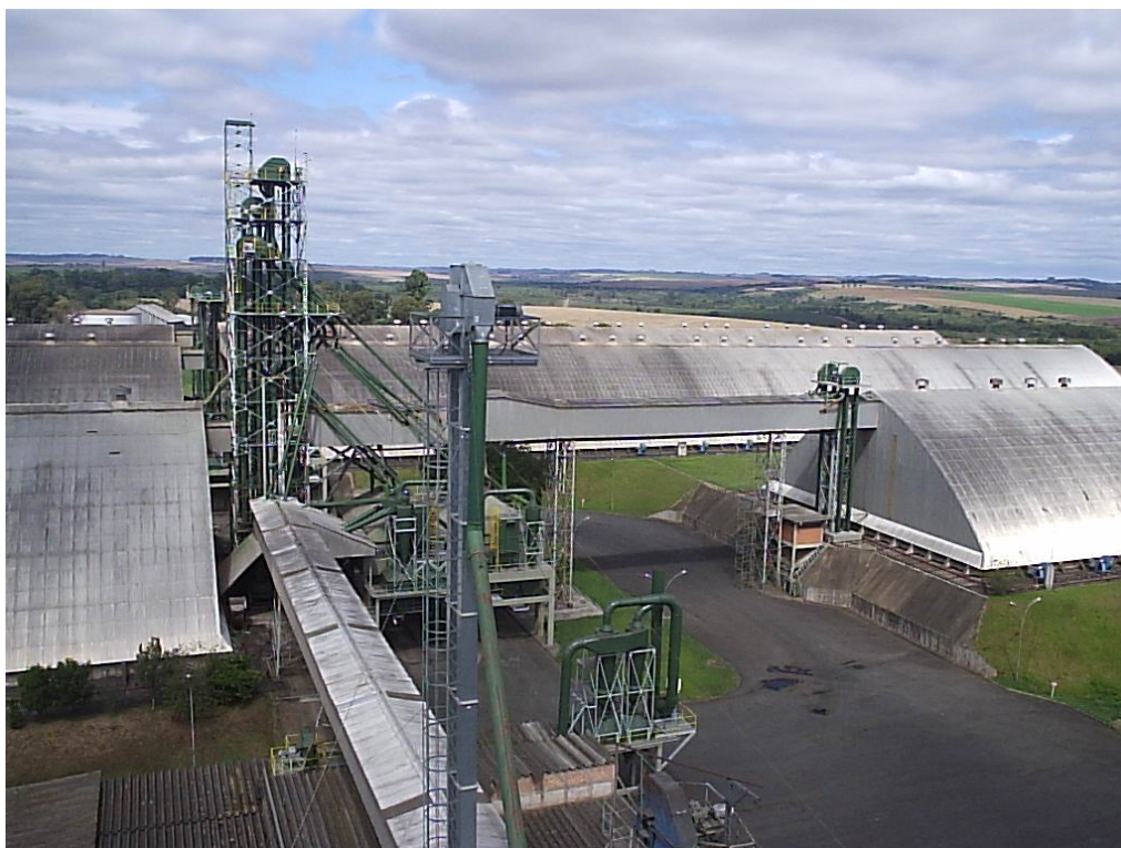
Figura 8 – Vista da estrutura geral da unidade armazenadora da CONAB localizada em Ponta Grossa-PR.
