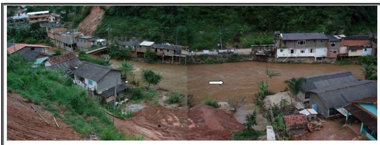
Figura 5.7 – Vista geral da área sujeita a inundações na margem direita e de solapamentos e deslizamentos na margem esquerda do rio Grande (Fonte Defesa Civil, 2007)
