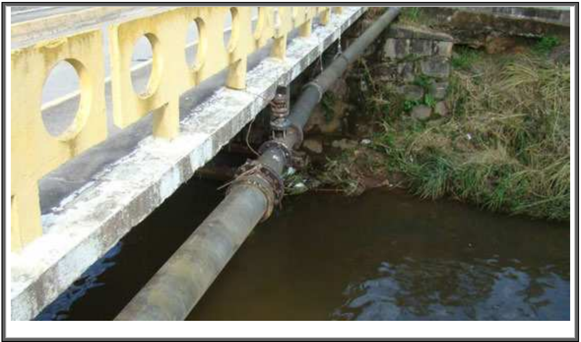
Figura 7.40 – Travessia de tubulação.
