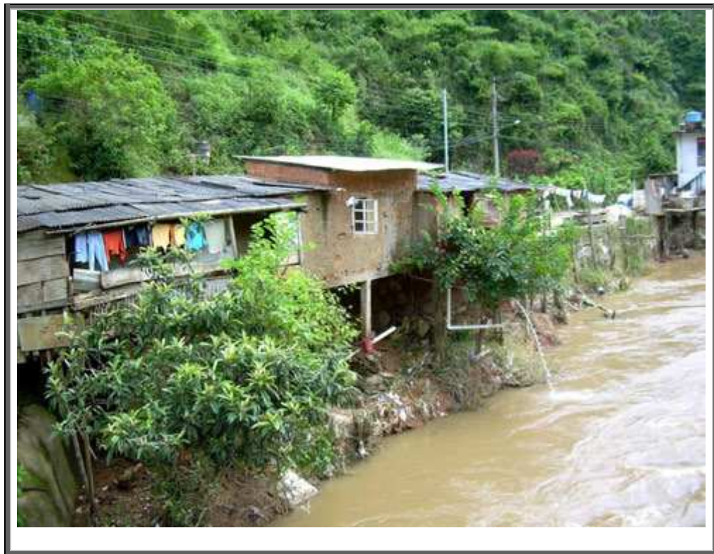
Figura 6.23 – Ocupação irregular em Riograndina, Nova Friburgo, janeiro de 2007. (Fonte: Defesa Civil).
