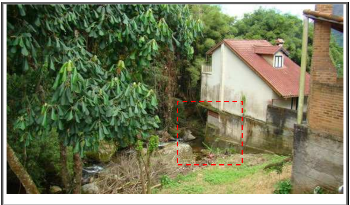
Figura 7.41 – Ocupação do leito e margens do rio Cônego.
