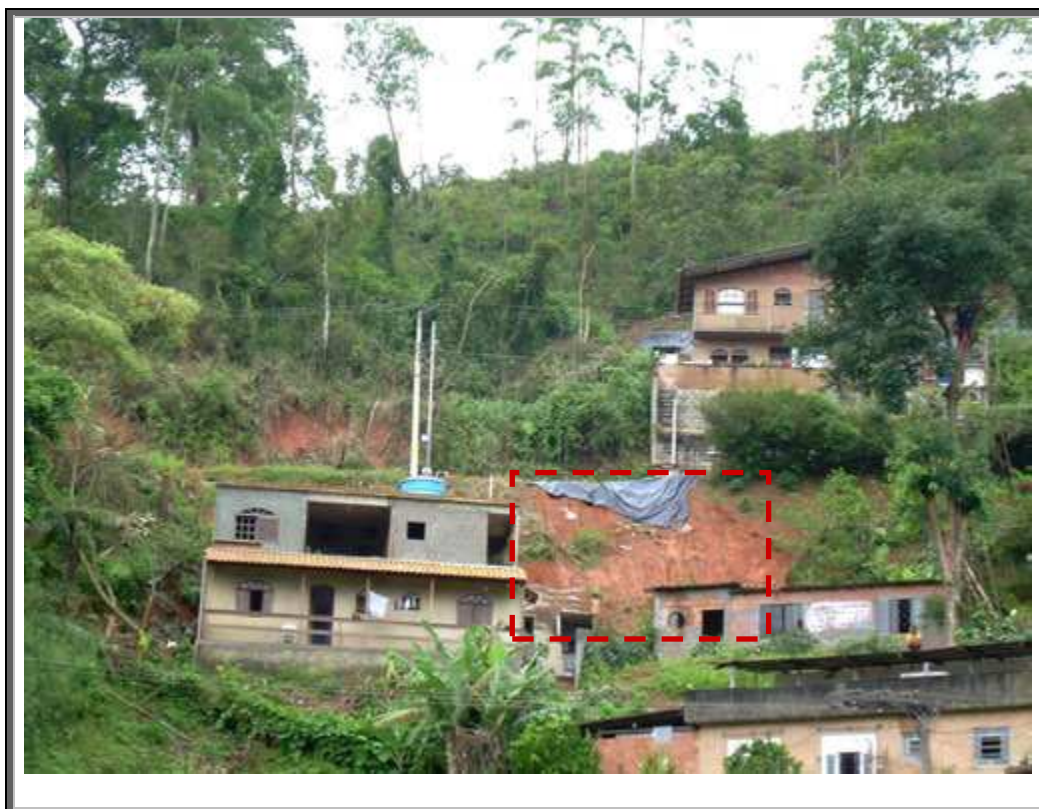
Figura 5.21 – Cicatriz de escorregamento e ocupação descriteriosa no bairro da Vilage, Nova Friburgo, janeiro de 2007 (Fonte: Defesa Civil).
