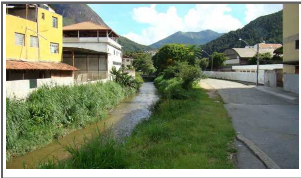
Figura 7.43 – Ocupação das margens do rio Cônego, bairro Olaria.
