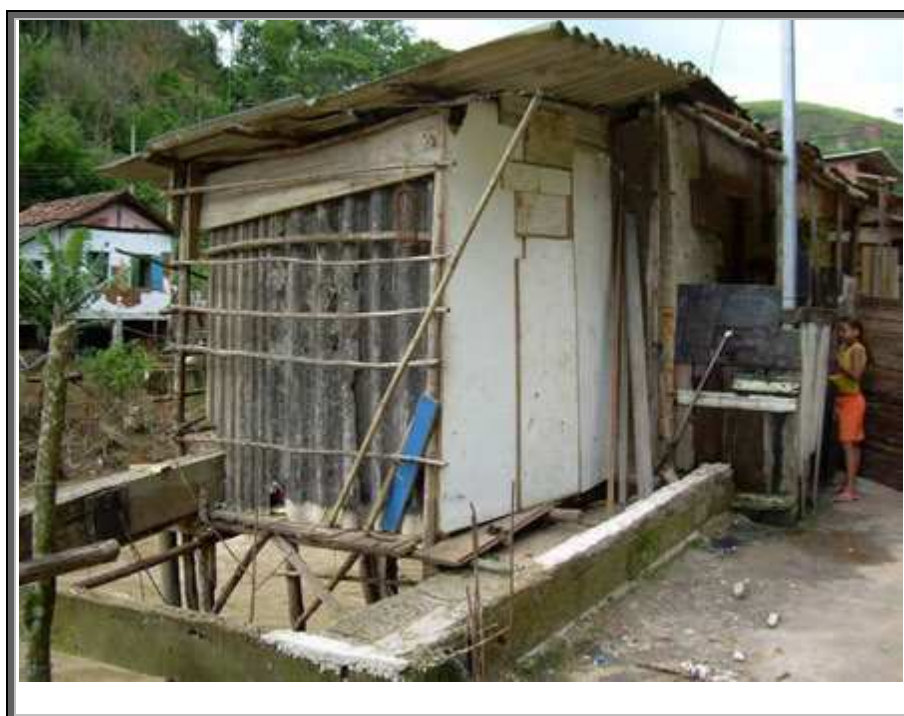
Figura 6.20 – Padrão construtivo tipo VI (Fonte: Defesa Civil, jan/2007).
