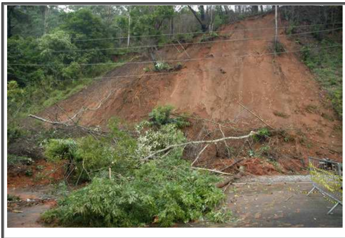
Figura 5.19 – Deslizamento de terra no bairro Duas Pedras, janeiro de 2007.
