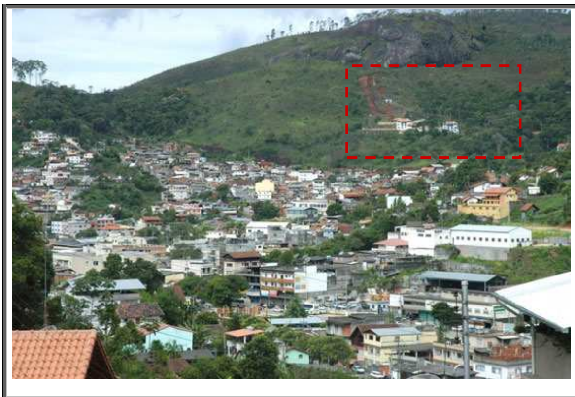
Figura 5.17 – Ocupação de terrenos de colúvio e tálus no bairro do Santo André, Nova Friburgo (Fonte: Defesa Civil, 2007).
