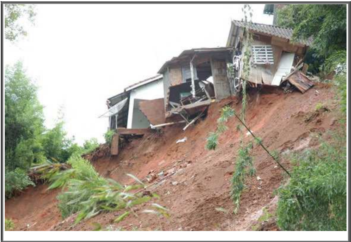
Figura 6.21 – Casas atingidas por deslizamento de terra, na localidade de Lagoinha, em janeiro de 2007 (Fonte: Defesa Civil).
