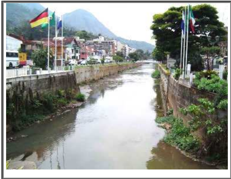
Figura 3.13 – Rio Bengalas, início da contenção das margens (Fonte: PMNF/FCTH, 2007).
