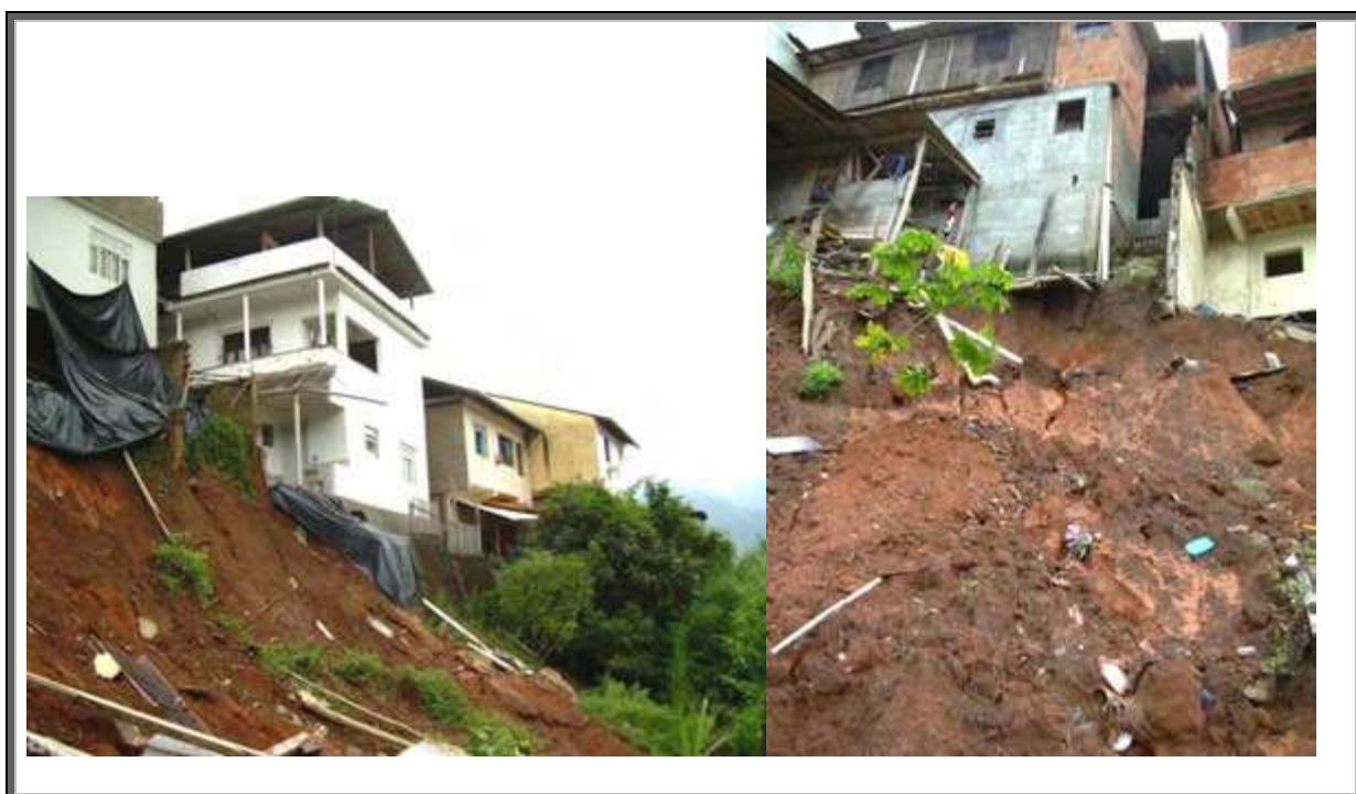
Figura 2.3 – Moradia desprovida de estrutura executada sem controle técnico, além da precariedade na coleta do esgoto domiciliar e do lixo, Bairro Olaria, Nova Friburgo – RJ (Fonte: Defesa Civil).
