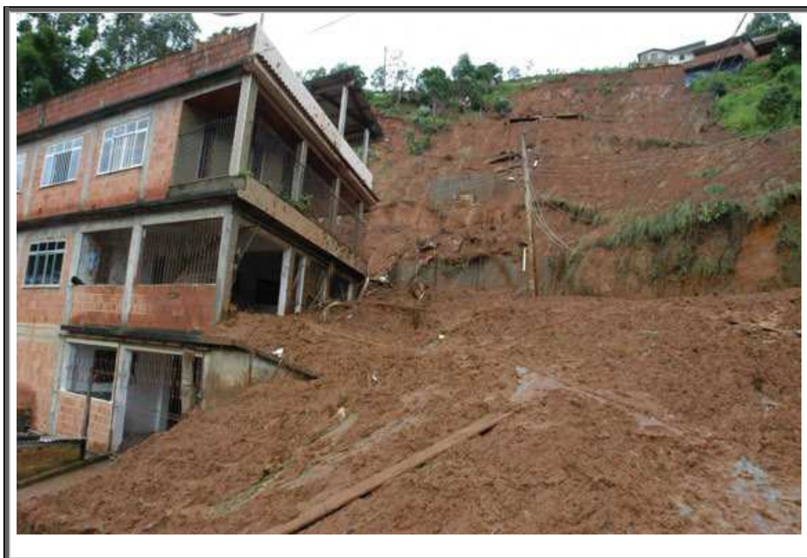
Figura 5.23 – Escorregamento de solo no bairro da Califórnia, Nova Friburgo, janeiro de 2007 (Fonte: Defesa Civil).
