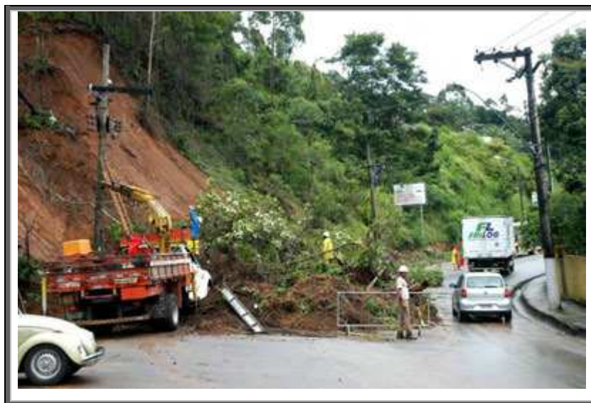
Figura 1.1 – Tráfego em meia pista devido ao deslizamento ocorrido no Km 1 da RJ-130, que liga o município de Nova Friburgo à Teresópolis. (Fonte: Defesa Civil).
