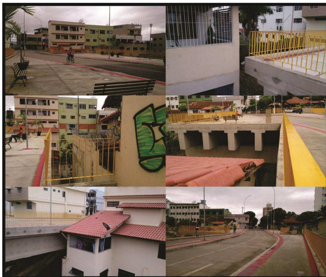
Figura 7 – Imagens tiradas durante a tarde em dias de semana em Aracruz, revelando o pouco uso de pessoas e veículos na obra, bem como sua proximidade com as residências.
