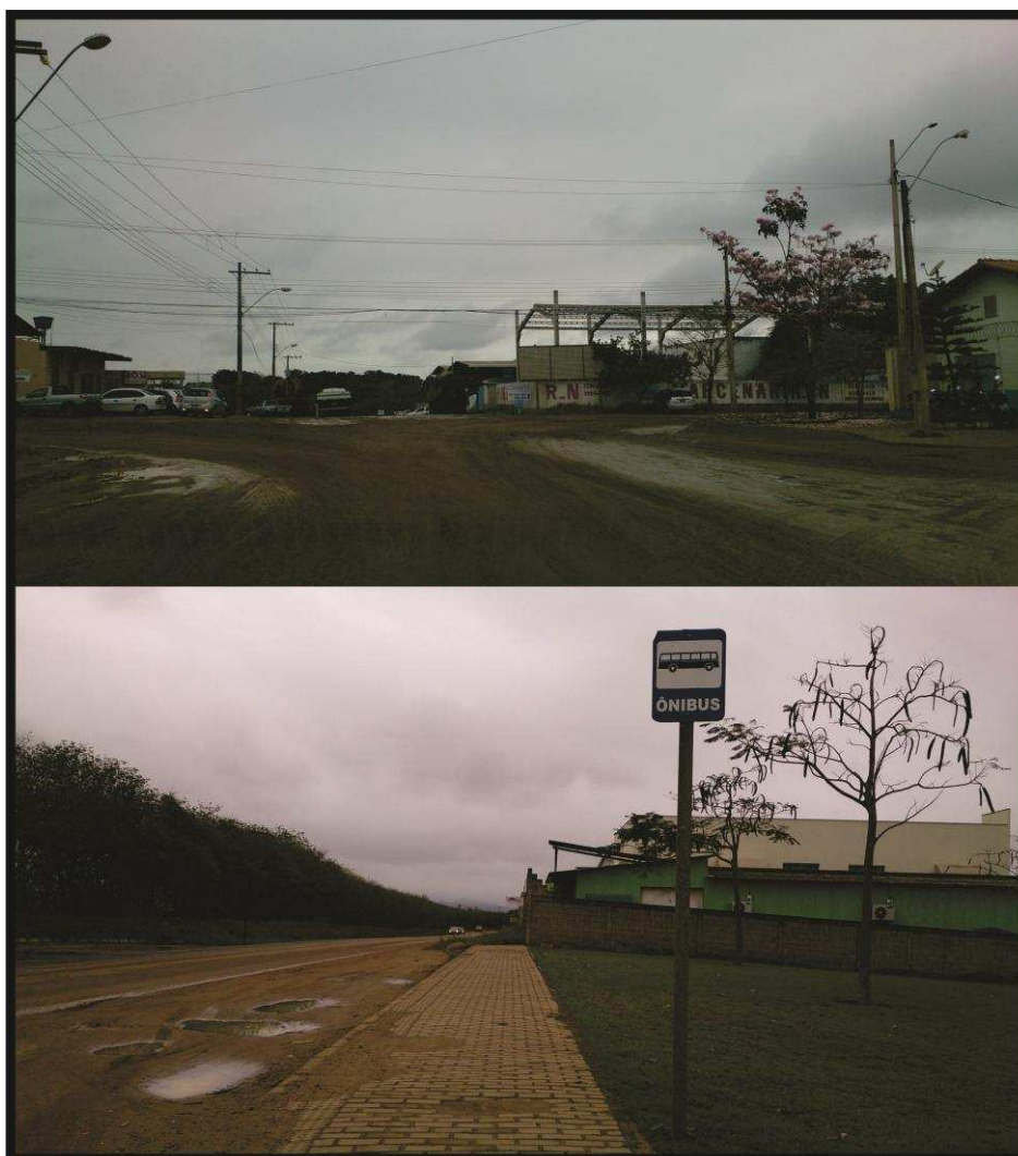
Figura 10 – Infraestrutura urbana no Centro Empresarial - Aracruz, falta de calçamento e ciclovias nas vias e de abrigo para os usuários de transporte coletivo.
