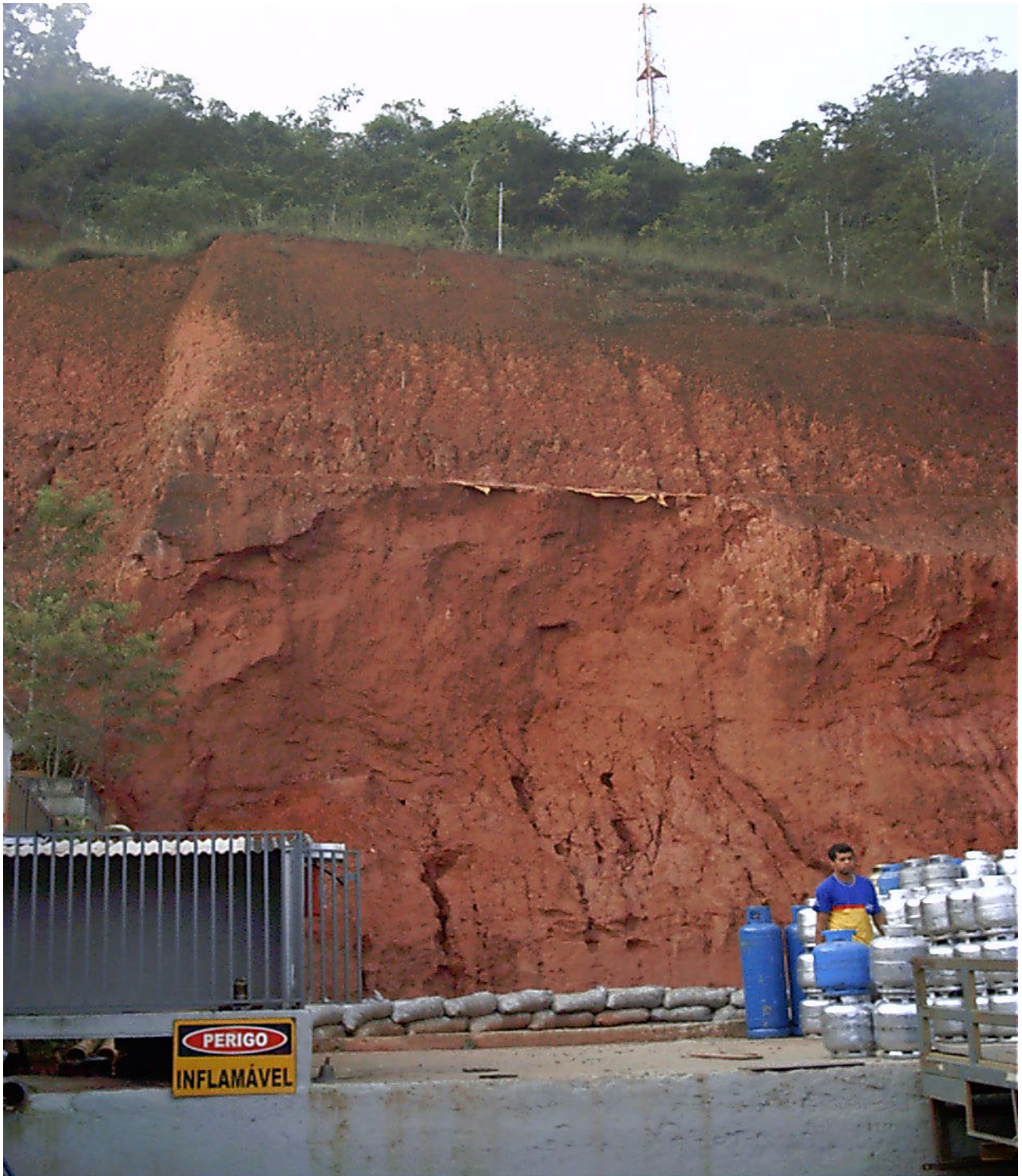
Figura 8 – Foto do talude MB.
