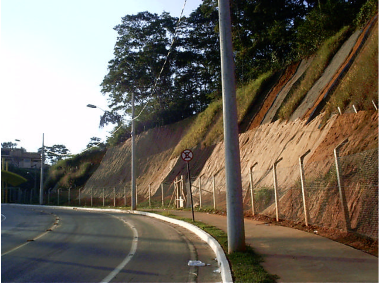
Figura 7 – Foto do talude VG.
