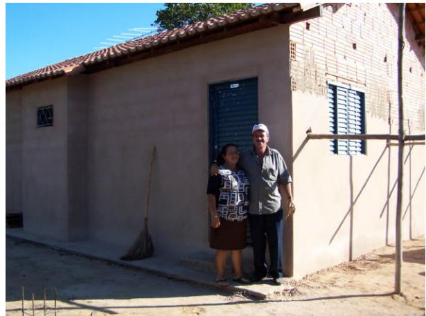
Figura 7 – Casa no PA Itatiaia, João Pinheiro/MG, 2010. Foto: Vera Teixeira, 2007.
