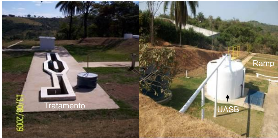
Figura 2 - Tratamento preliminar, UASB e rampa de escoamento superficial da Estação de tratamento de esgoto da COPASA – APAC na cidade de Santa Luzia.
