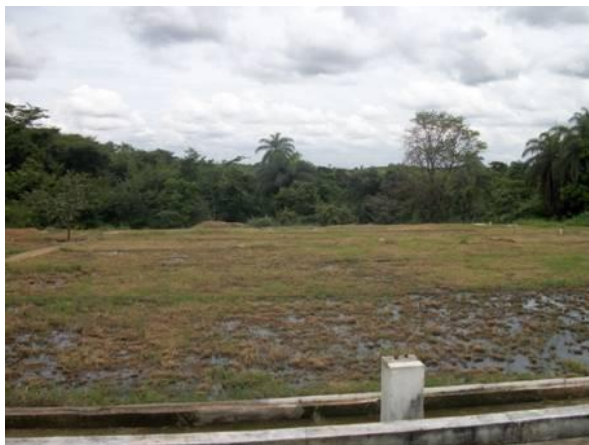
Figura 3 - Rampa de escoamento superficial da Estação de tratamento de esgoto da COPASA – APAC na cidade de Santa Luzia.
