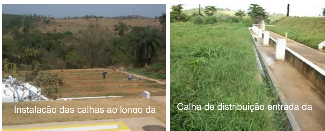
Figura 20 - Detalhe da instalação das calhas para regularização da vazão e calha de distribuição no início da rampa de Escoamento Superficial utilizada na pesquisa.
