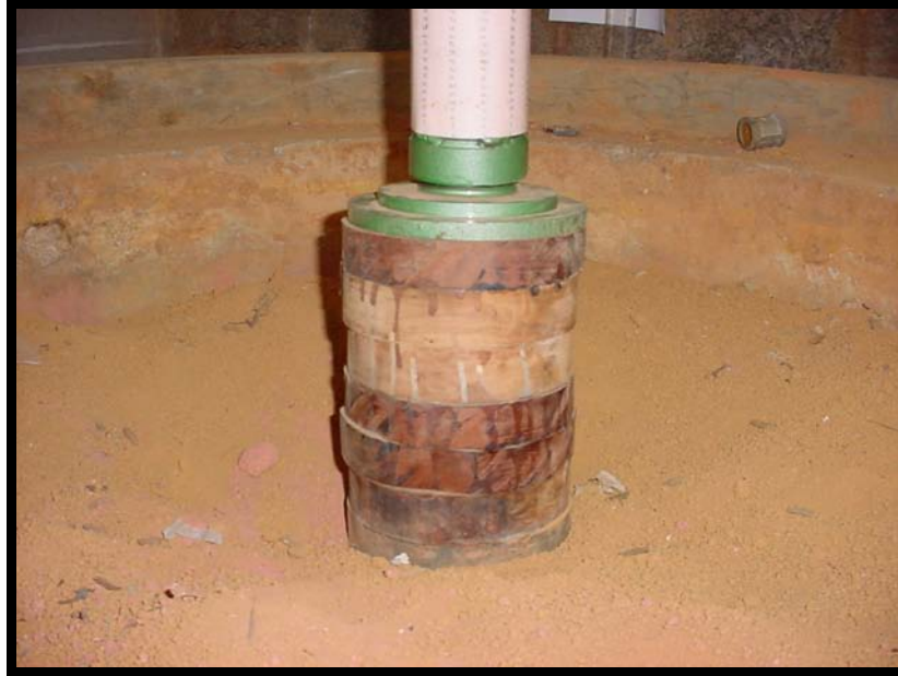
Figura 36 – Vista aproximada da sapata.
