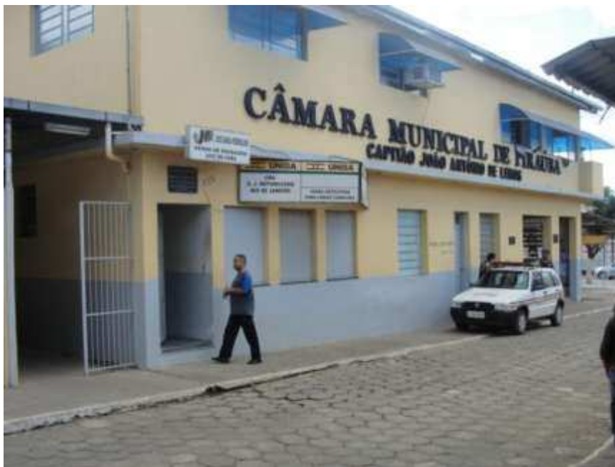
Figura 15- Fotografia da fachada de um prédio público no município de Piraúba - MG.
